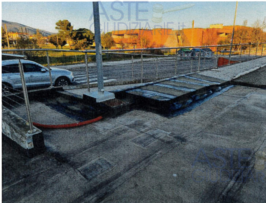
Dettaglio impermeabilizzazione copertura lotti n.3 e n.4
