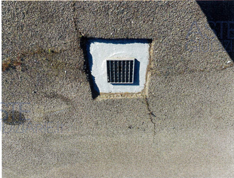
Dettaglio ripulitura e impermeabilizzazione pozzetti di raccolta acqua piovana
