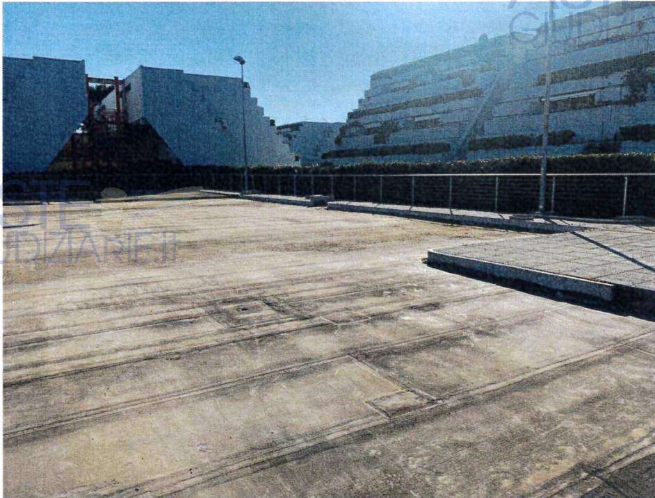
Panoramica lavori di pulizia effettuati
