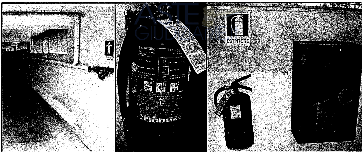
Impianto antincendio: tubazioni, estintore, naspo
