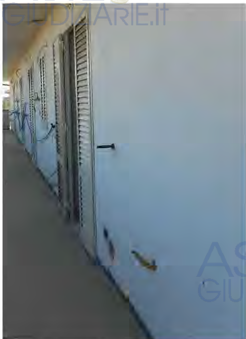
Punto di partenza impianto sottotraccia
