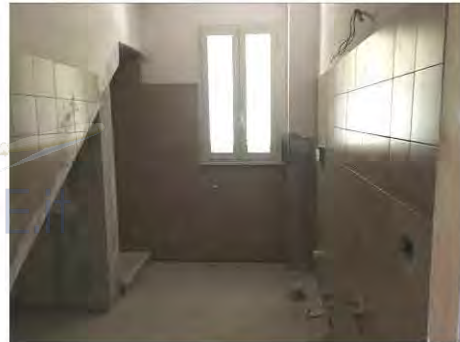
Bagno piano primo
