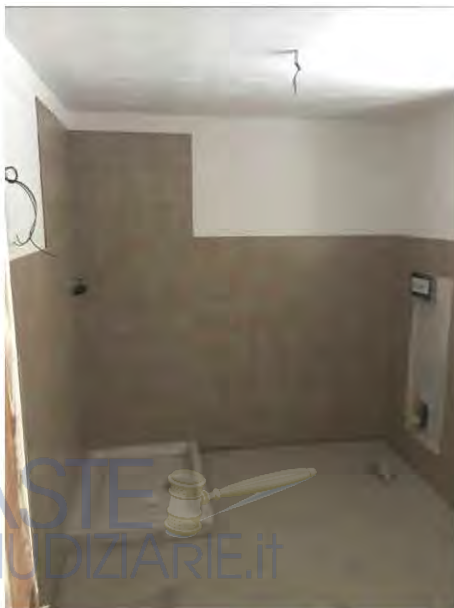
Bagno deposito occasionale piano sottotetto
