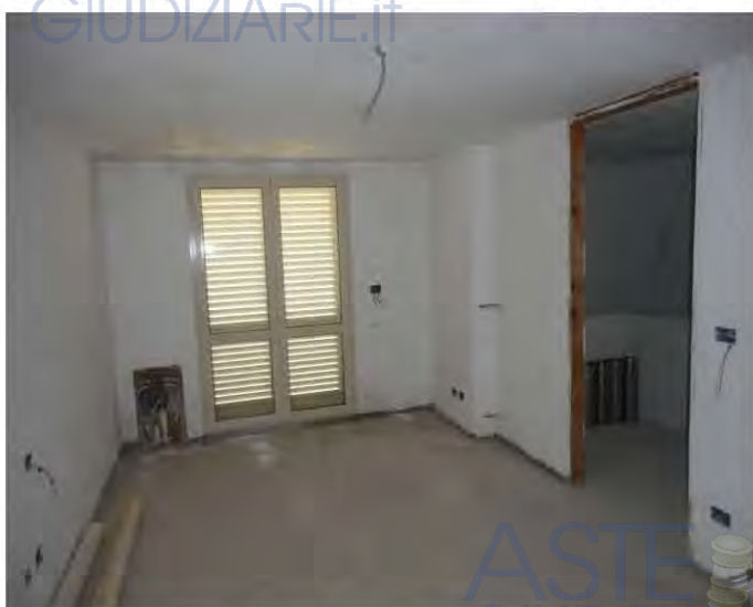
Deposito occasionale sottotetto
