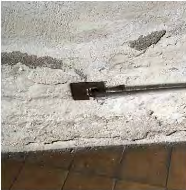
Preso elettrica magazzino
