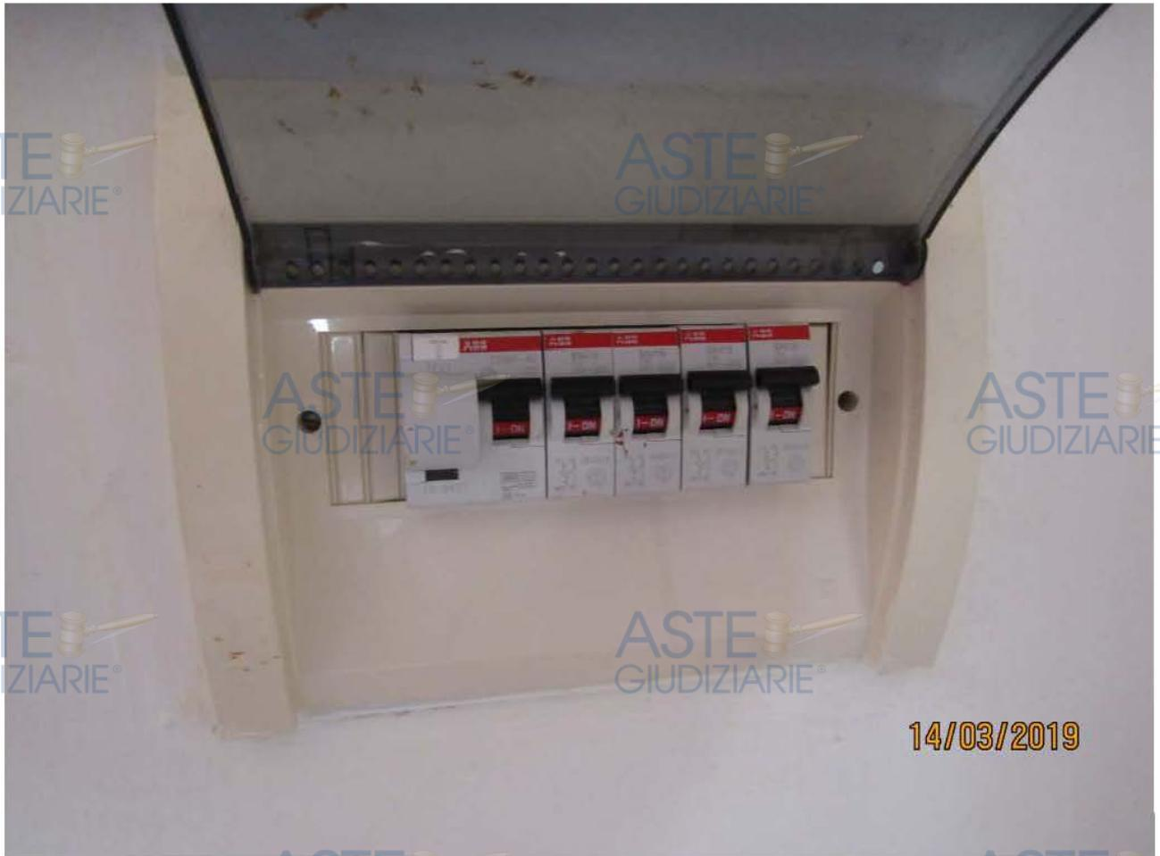
Trattasi di quadro elettrico del tipo ad incasso, da 8 moduli, classe di isolamento 2.
