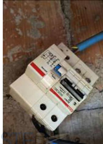
A tale dispositivo sono collegati conduttori che raggiungono, tramite corrugati sottotraccia e interrati, il quadro elettrico di distribuzione, posizionato all'interno dell'appartamento al piano terra.
