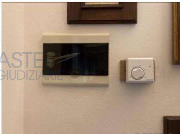
Nel quadro elettrico sono presenti le indicazioni per l'identificazione delle linee alimentate dai vari dispositivi ma non è presente la targa identificativa del quadro, come invece previsto dalla Norma CEI 23-51.
