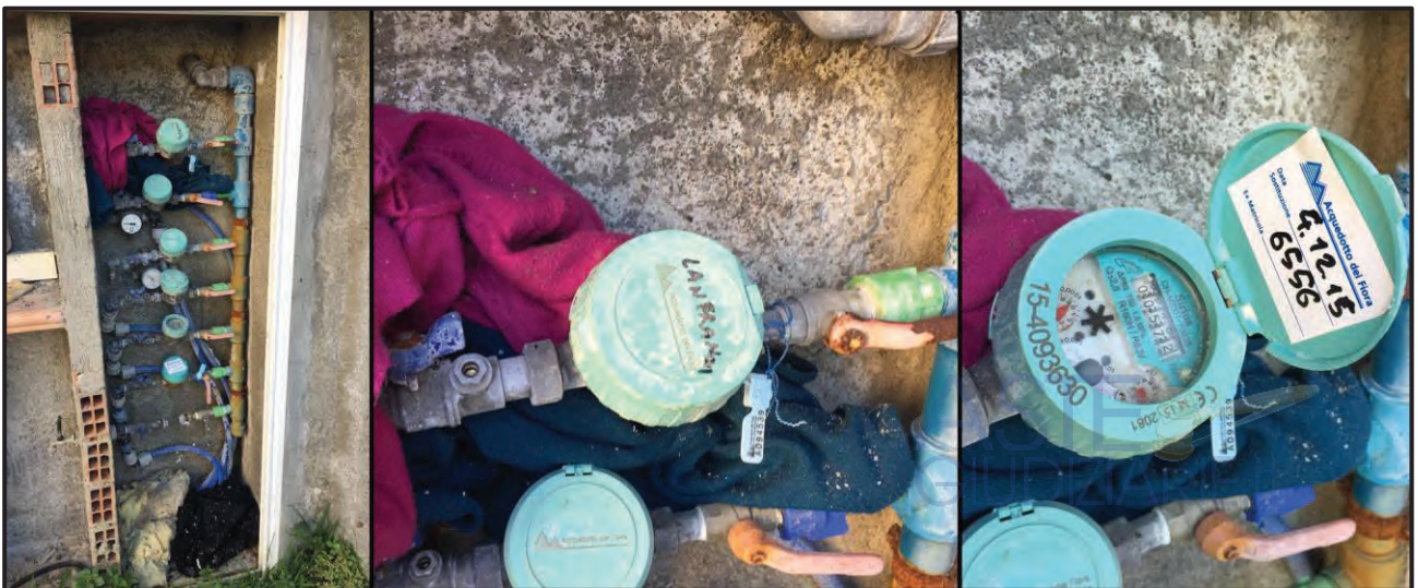
Punto di fornitura e contatore acquedotto del Fiora
