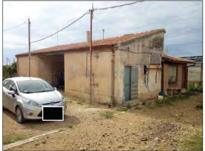
Vista esterna nord/ovest
