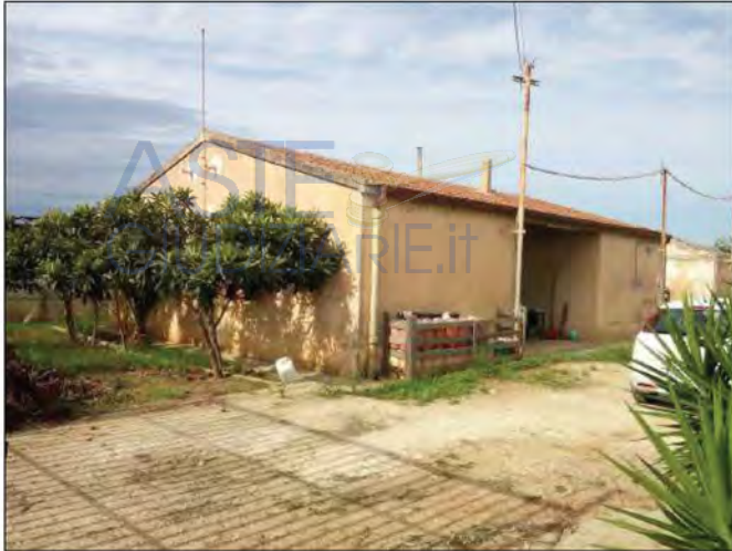
Vista esterna nord/est
