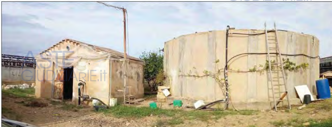
(B) e (C) - Locale pompa e Vasca di riserva idrica (ubicati all'interno della part.IIa 50)
