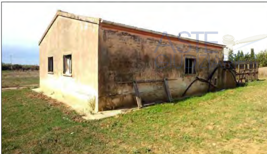
Vista esterna nord/est
