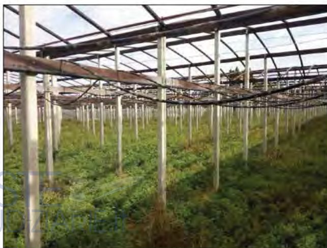
(F) - vista interna Serre a padiglione in struttura mista
