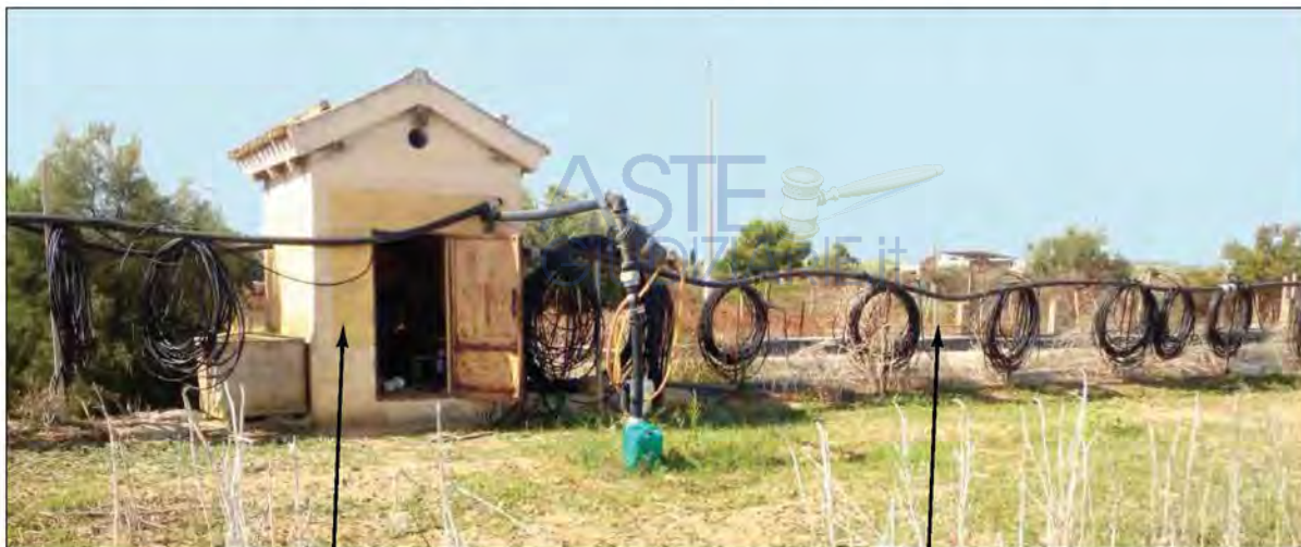
E) Casotto locale pompe e apparecchiature idrauliche
