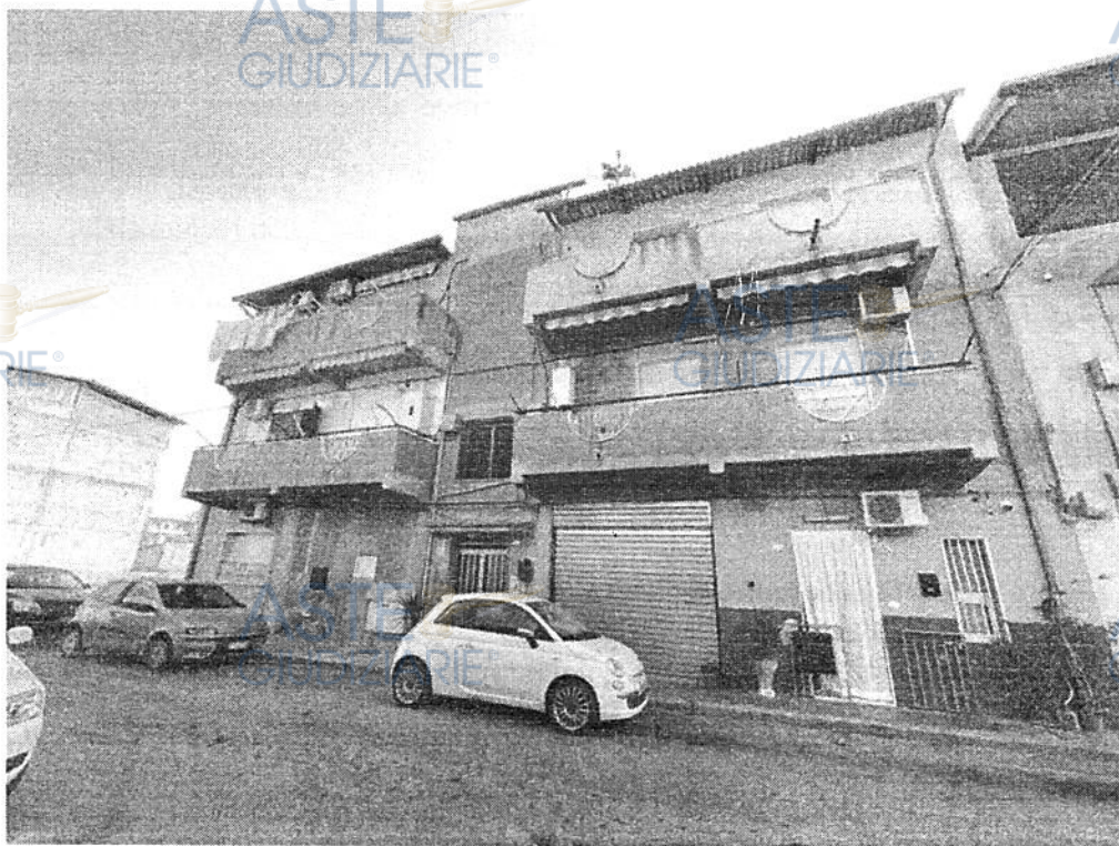
Foto 2 – Prospetto principale dell'immobile su via Parnaso
