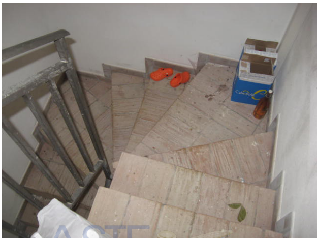
Scala accesso cantina e particolare cantina
