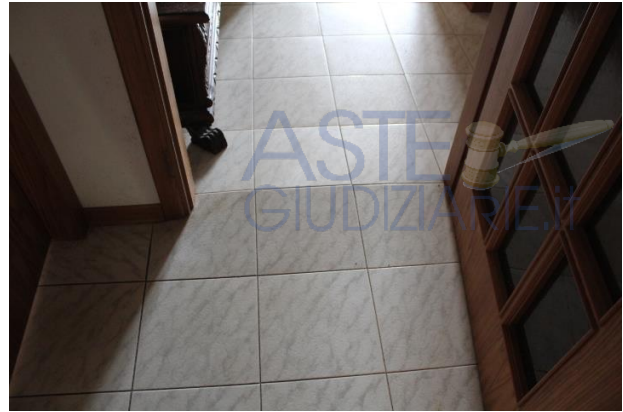
PARTICOLARE SOLLEVAMENTO DELLA PAVIMENTAZIONE AL DISIMPEGNO PIANO PRIMO
