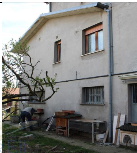
PORZIONE DI PROSPETTO NORD
