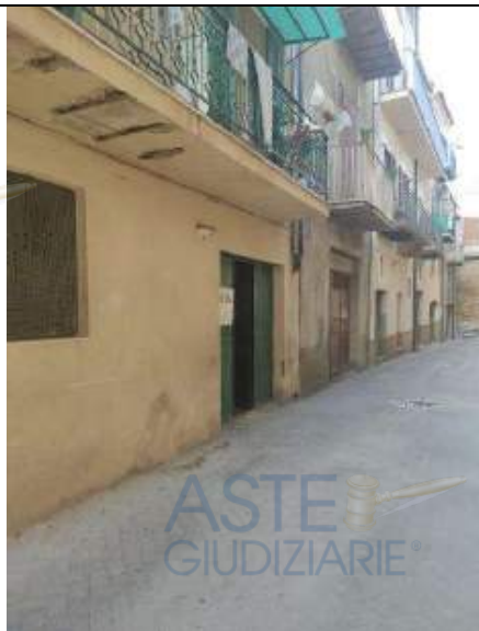
F.3 Via Tortorici Cremona Unità immobiliare 2. Piano terra al civico 36
