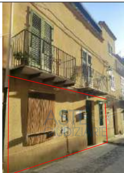
F.1 Ingresso unità immobiliare1. Via Giuseppe Garibaldi,35
