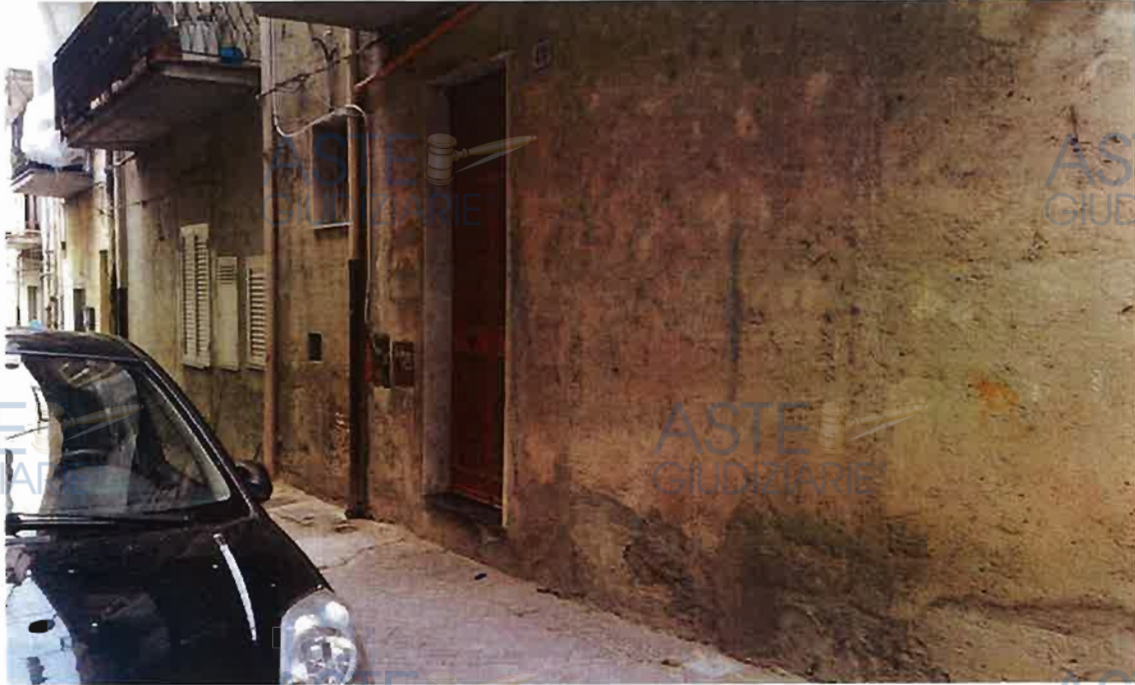
Foto n.1: Prospetto su Via Penaro
