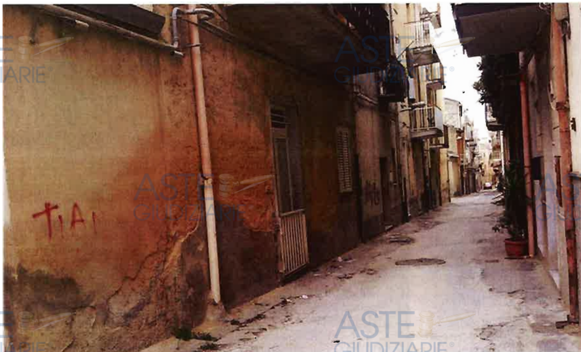
Foto n.2: Prospetto su Via Nuova
