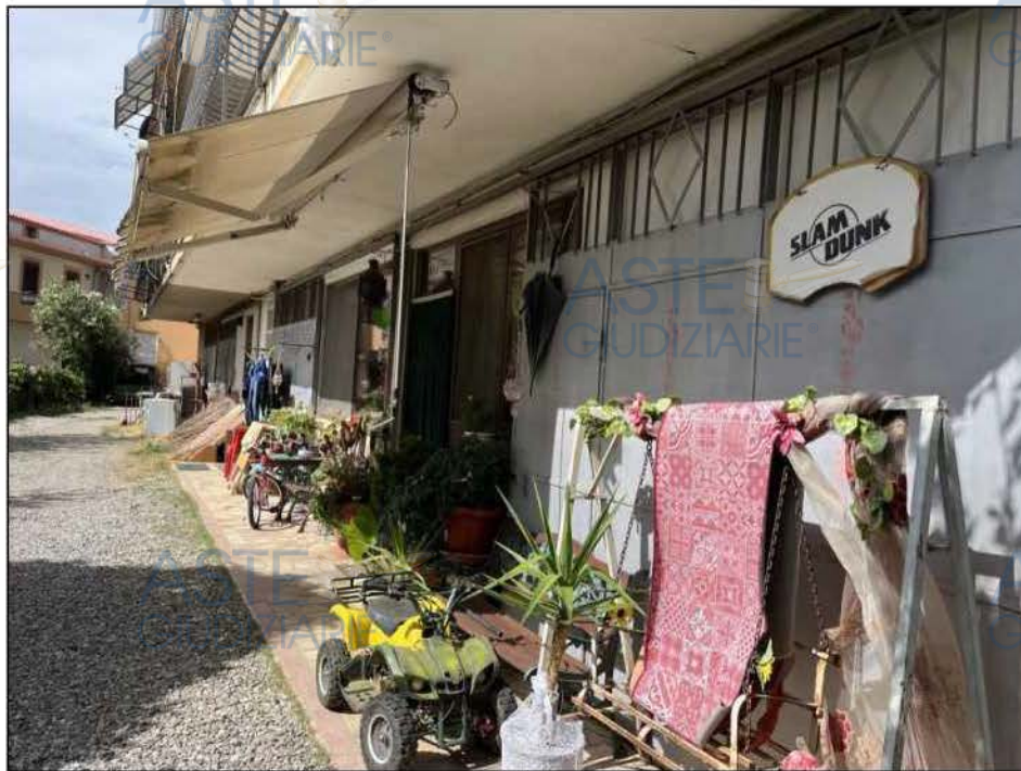
Fig. 8 - FOTO FABBRICATO lato posteriore - BENI SITI IN COMUNE DI ZAGARISE (INGRESSO UNITA' IMMOBILIARE PIANO TERRA SUB 3)
