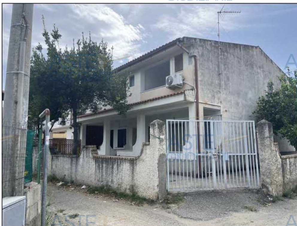
Fig. 14 — Vista esterno fabbricato
