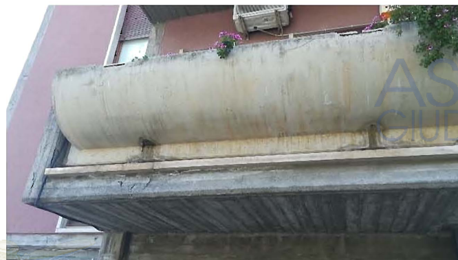
Vista del balcone su strada condominiale
