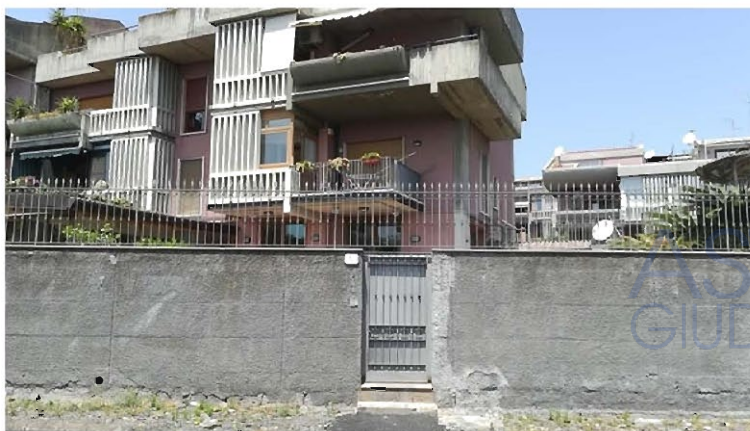
Vista di altro ingresso da via Sgroppillo n.5
