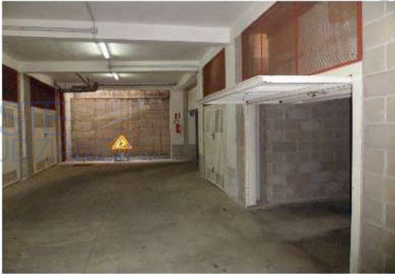
Foto n°3-Corridoio di accesso ai garages
