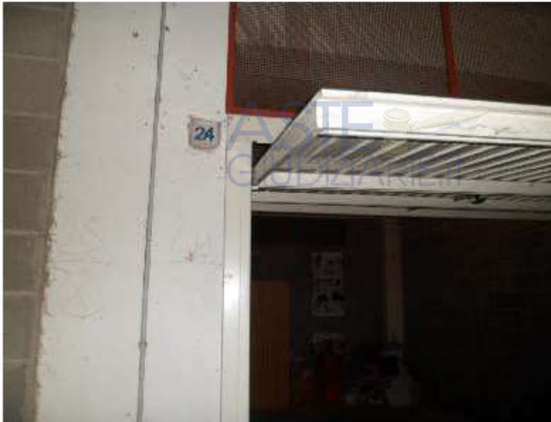
Foto n°4-Garage sub 66 al n° 24
