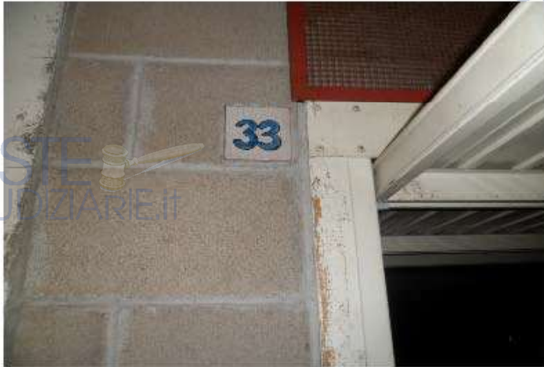
Foto n°7- Garage Sub 75 al n°33
