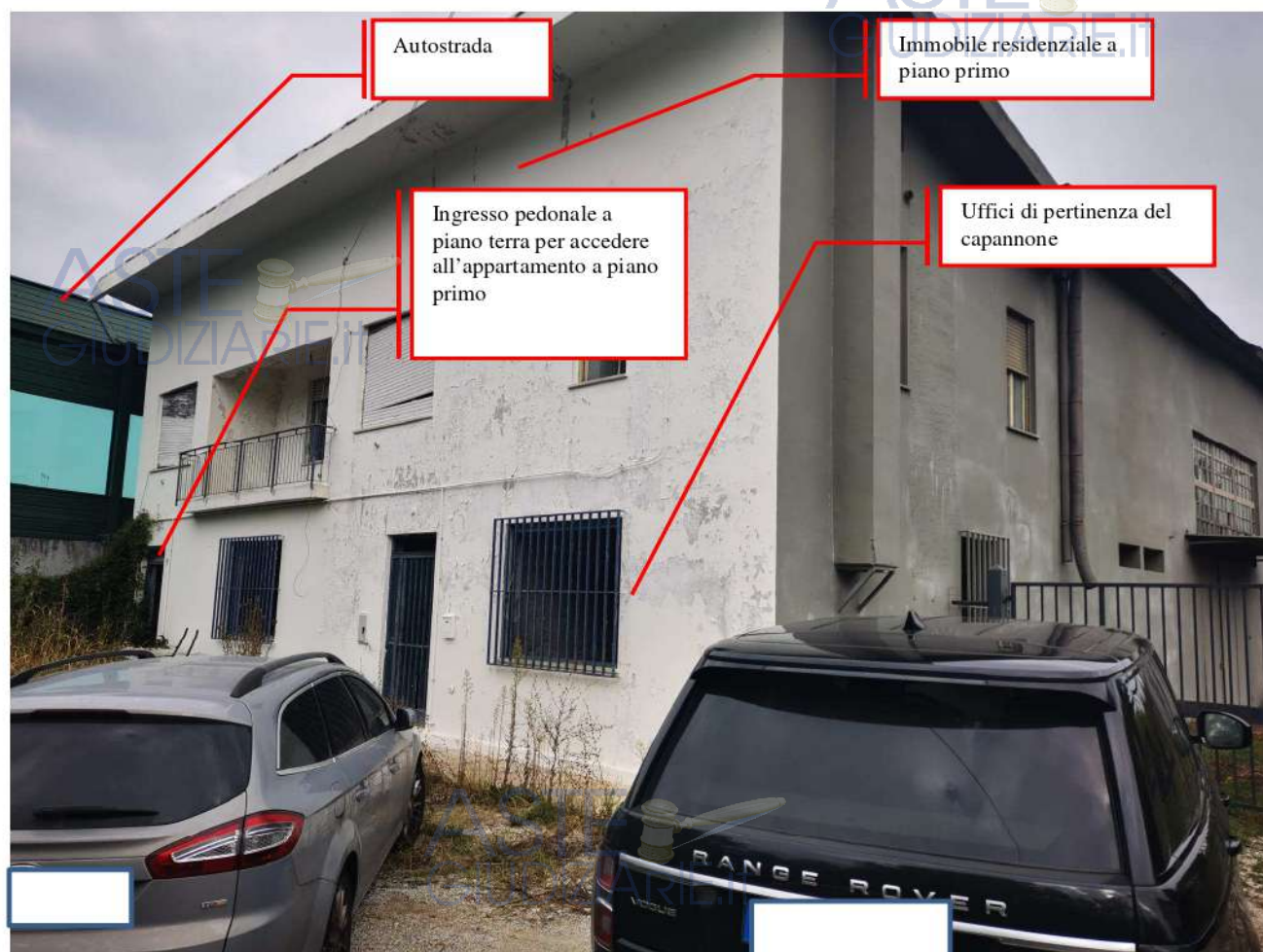
Figura 26- Visualizzazione dell'edificio lungo la Via Forgia- visualizzazione della facciata sud della struttura con individuazione del piano terra costituente accessorio del capannone e del piano primo costituente immobile a carattere residenziale di pertinenza dello stesso capannone
