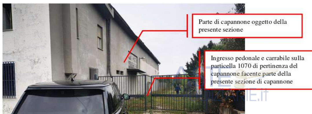
Figura 27- Visualizzazione dell'ingresso carrabile e pedonale costituente corte del fabbricato ed individuato con la particella 1070
