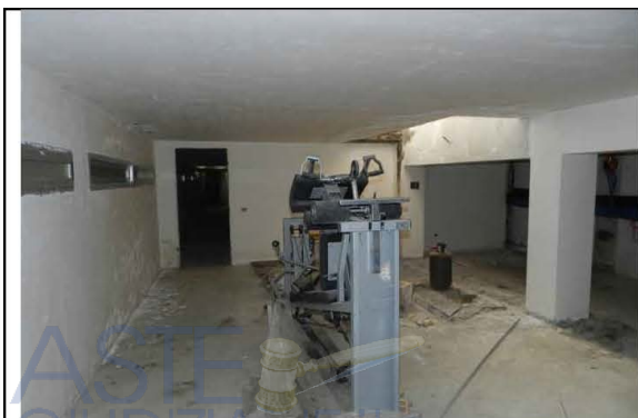
foto n° 6: Vista interna del locale
