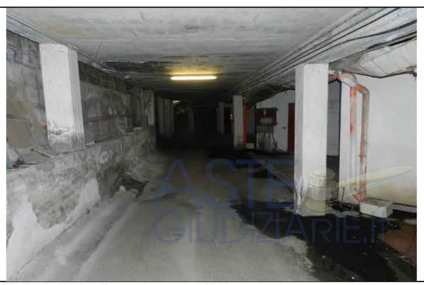
foto n° 3: Corsia carrabile al piano cantinato
