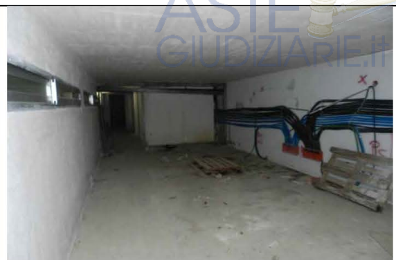
foto n° 7: Vista interna del locale
