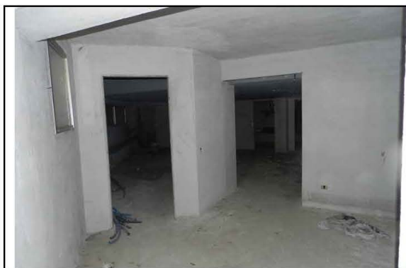
foto n° 4: Vista interna del locale
