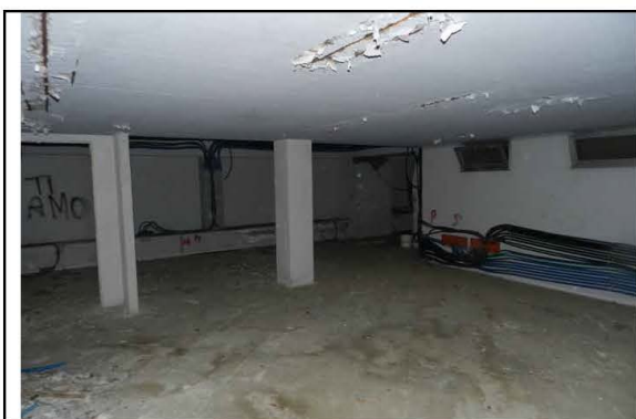
foto n° 8: Vista interna del locale
