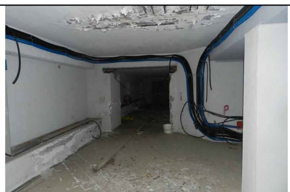
foto n° 9: Vista interna del locale
