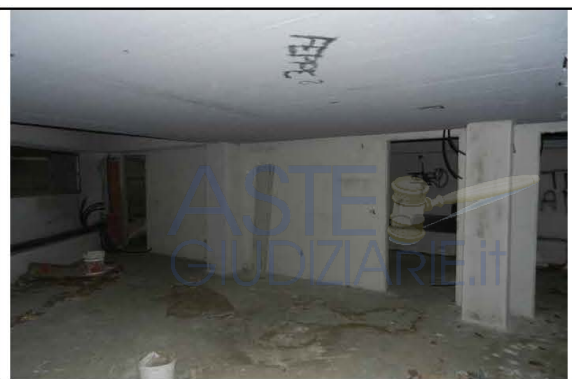
foto n° 5: Vista interna del locale
