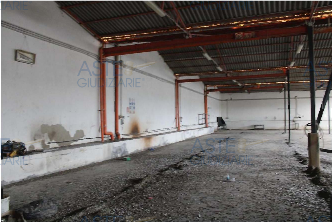
Interno del capannone industria
