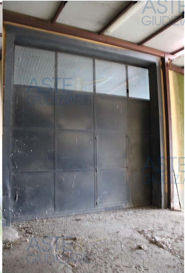
accesso al capannone industriale
