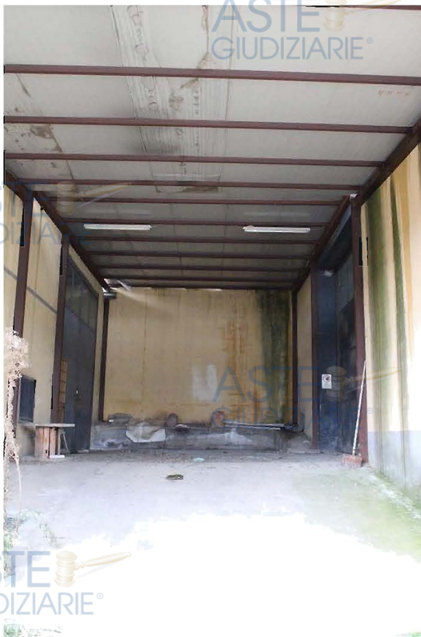
Corridoio di accesso interno
