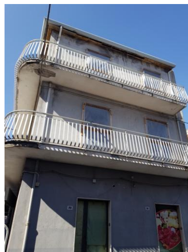
Condizioni attuali dell'edificio riscontrato in seno al sopralluogo
