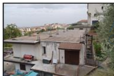
foto della copertura
