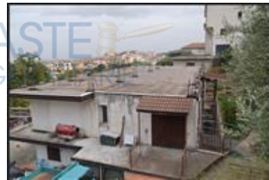
foto della copertura
