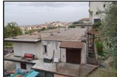
foto della copertura
