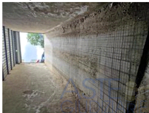
Immagine della rampa di accesso al piano seminterrato, provenendo dall'esterno. (foto da ruotare).
