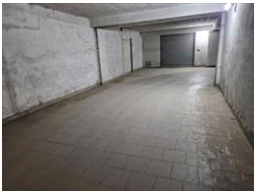
Corsia di accesso che conduce al box al piano S1, prelevando dalla rampa di accesso.
