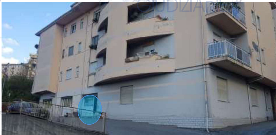
foto 1 – Vista prospettica fabbricato
