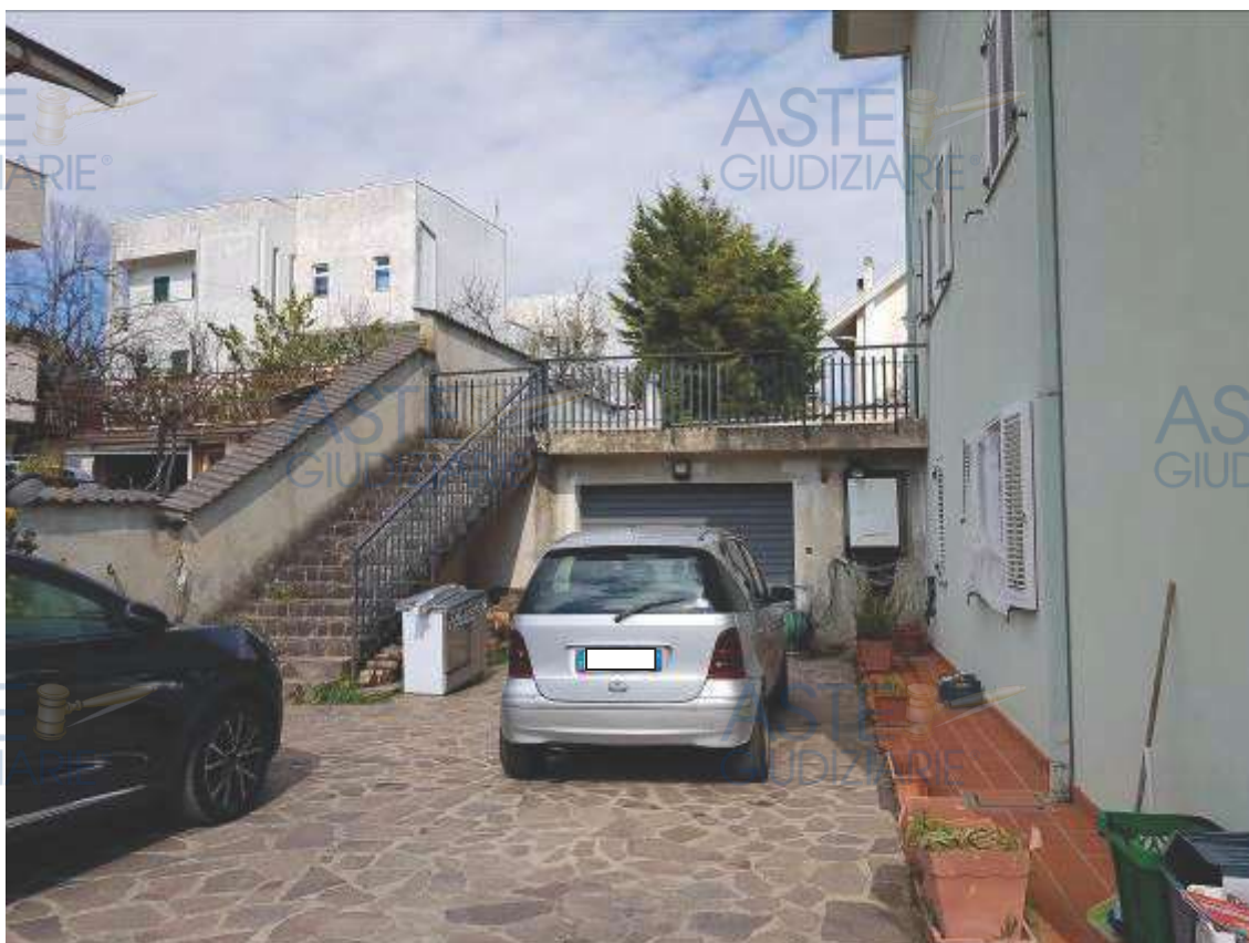
INGRESSO AL GARAGE E SCALE CHE COLLEGANO IL PIANO TERRA ALLA CORTE DEL PRIMO PIANO
