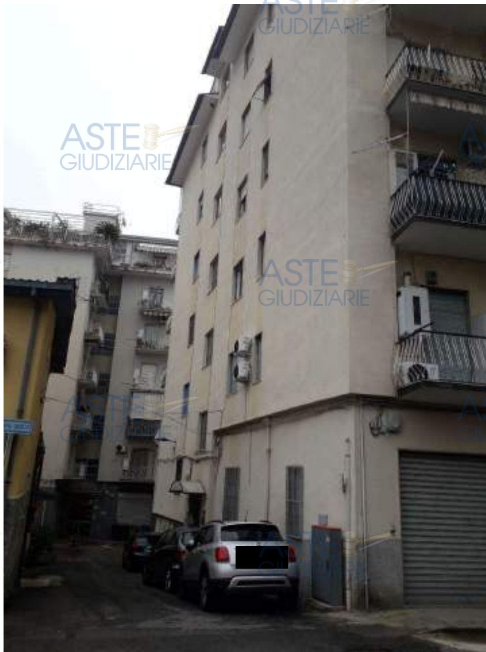
Foto N.2: Prospetto fabbricato Nord con ingresso condominiale ai vari piani.
