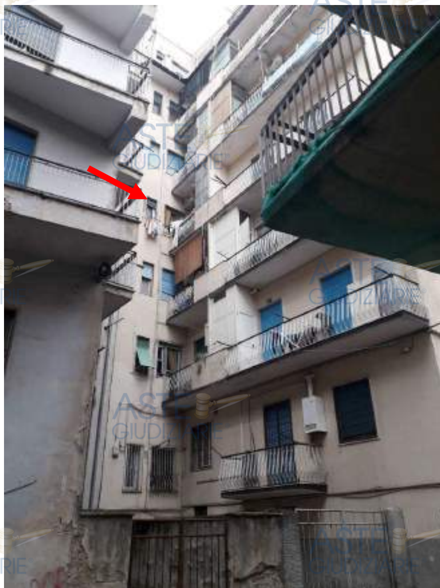
Foto N.4: Prospetto fabbricato Sud
