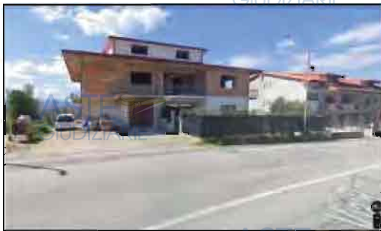
Fig. n.2 – Vista del fabbricato in cui ricade la porzione immobiliare oggetto di pignoramento dalla Via Roma (prospetto Nord – Est)
