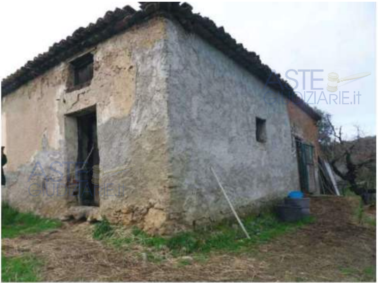
FOTO N. 149: Prospetto SUD – EST Bene N. 3
