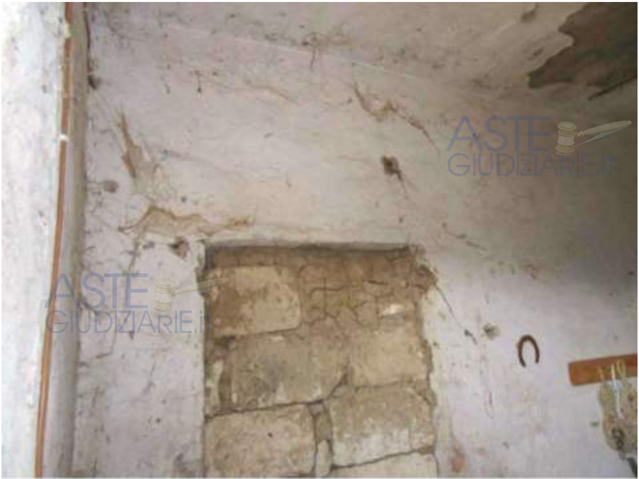
FOTO N. 125: Interni Bene N. 2
