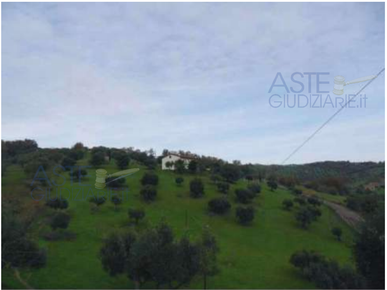
FOTO N. 153: Vista Bene N. 1 da Bene N. 3
