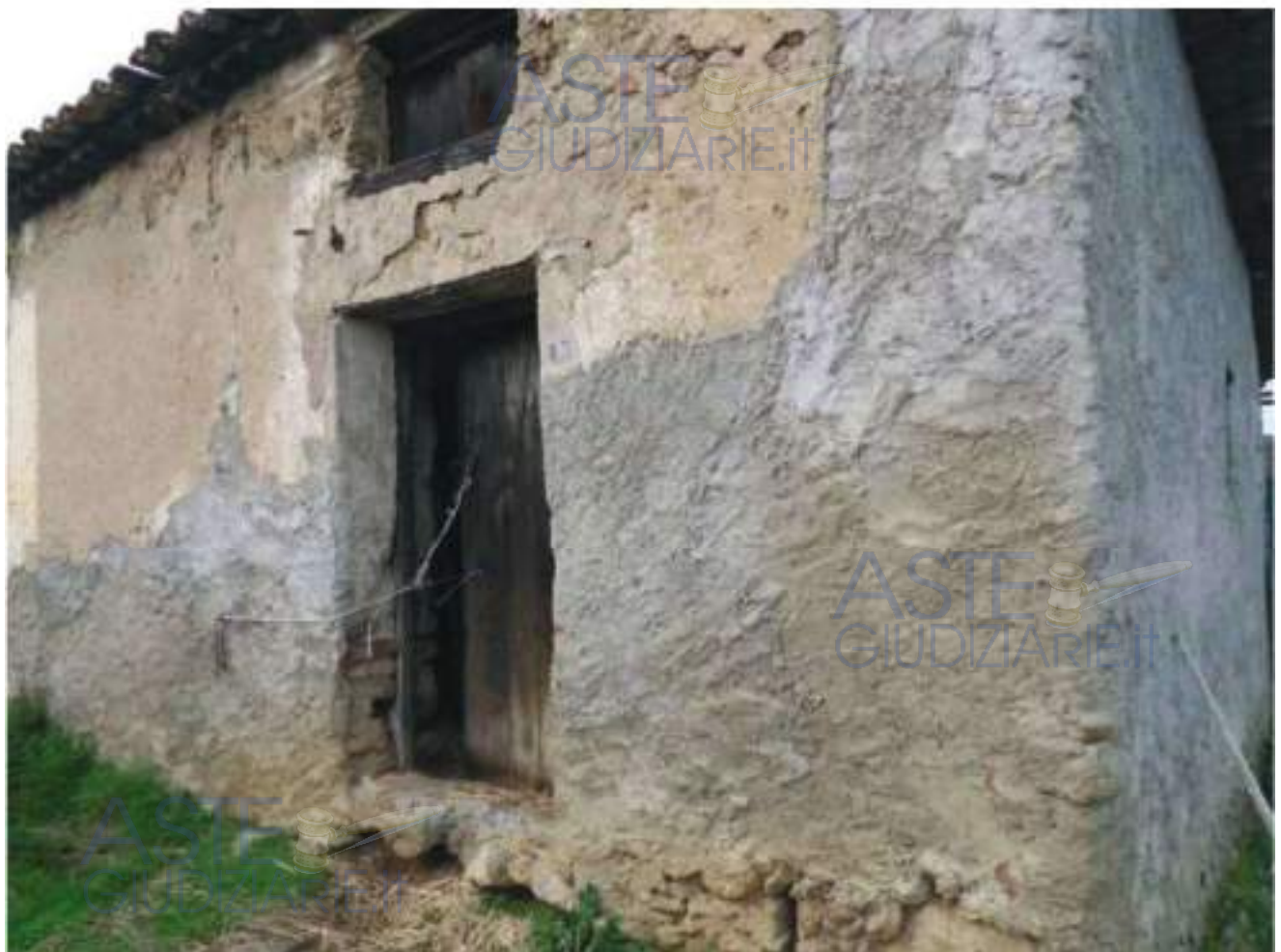
FOTO N. 138: Prospetto SUD – EST Bene N. 3
