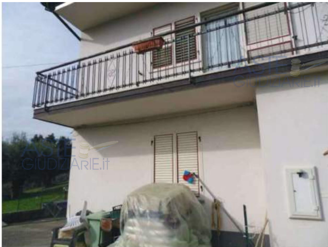
FOTO N. 5: Prospetto SUD - EST Bene N. 1
