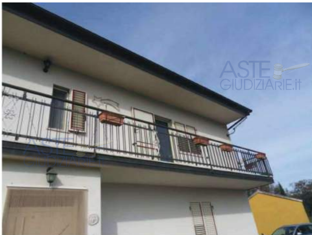
FOTO N. 7: Prospetto SUD - EST Bene N. 1
