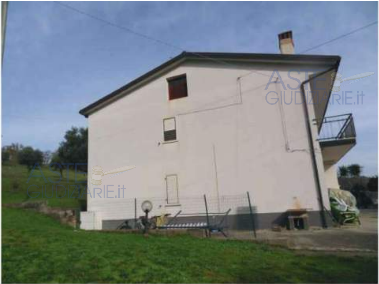
FOTO N. 15: Prospetto SUD - OVEST Bene N. 1
