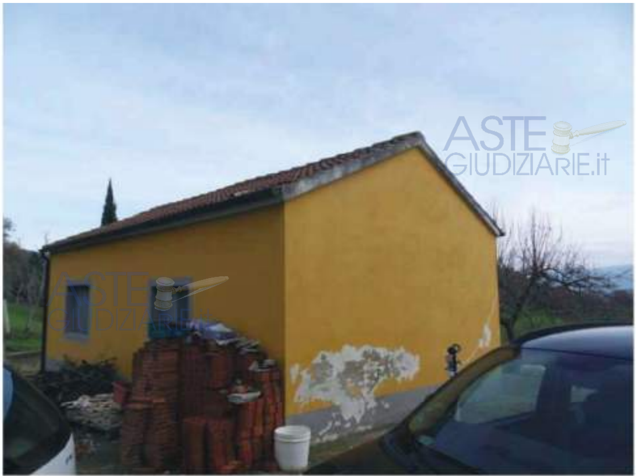
FOTO N. 135: Prospetto NORD – OVEST Bene N. 2
