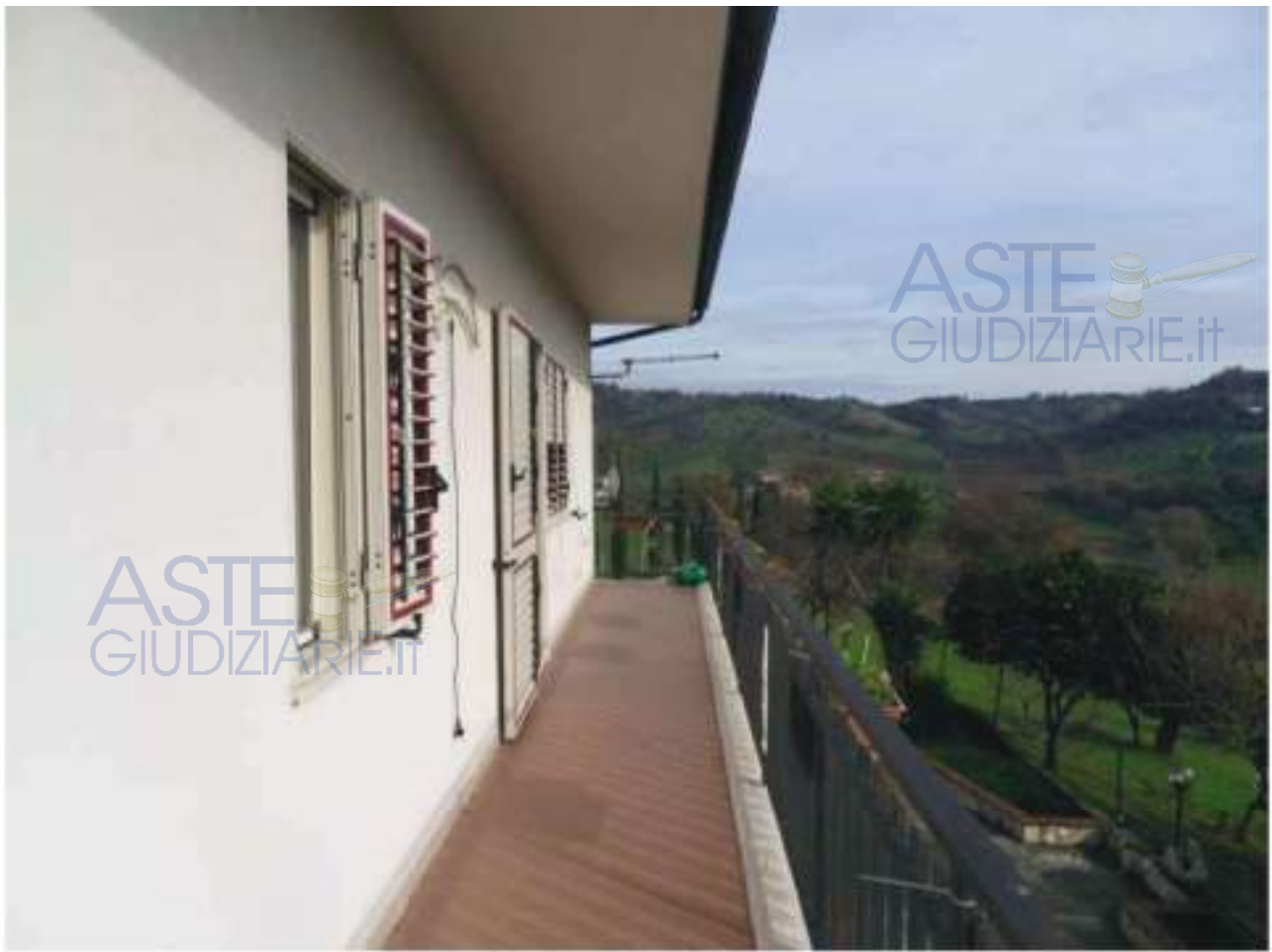
FOTO N. 79: Esterni Bene N. 1 (PIANO PRIMO - Balcone)
