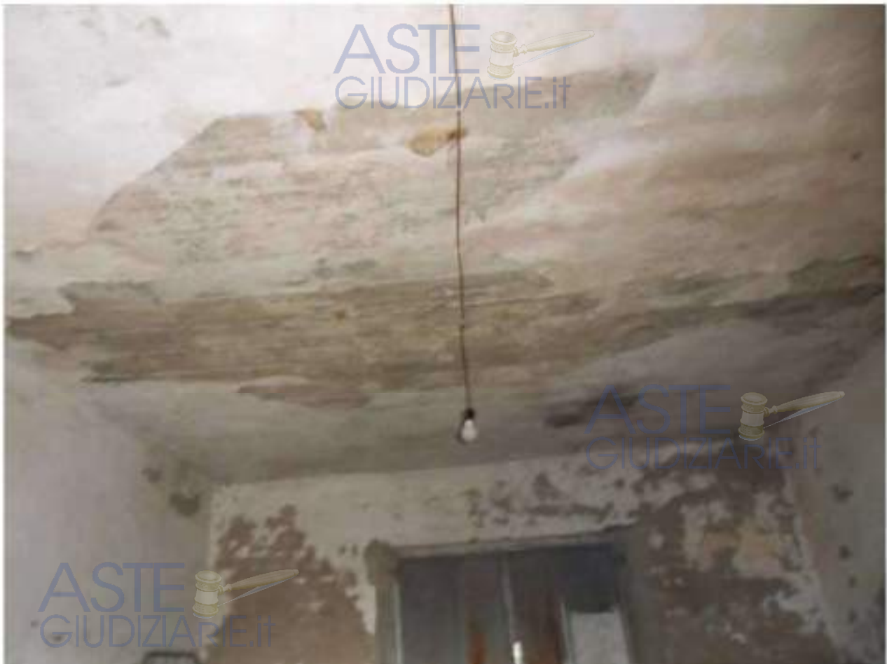
FOTO N. 128: Interni Bene N. 2
