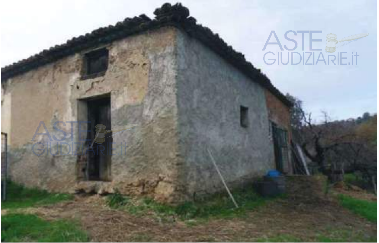
FOTO N. 137: Prospetto SUD – EST Bene N. 3
