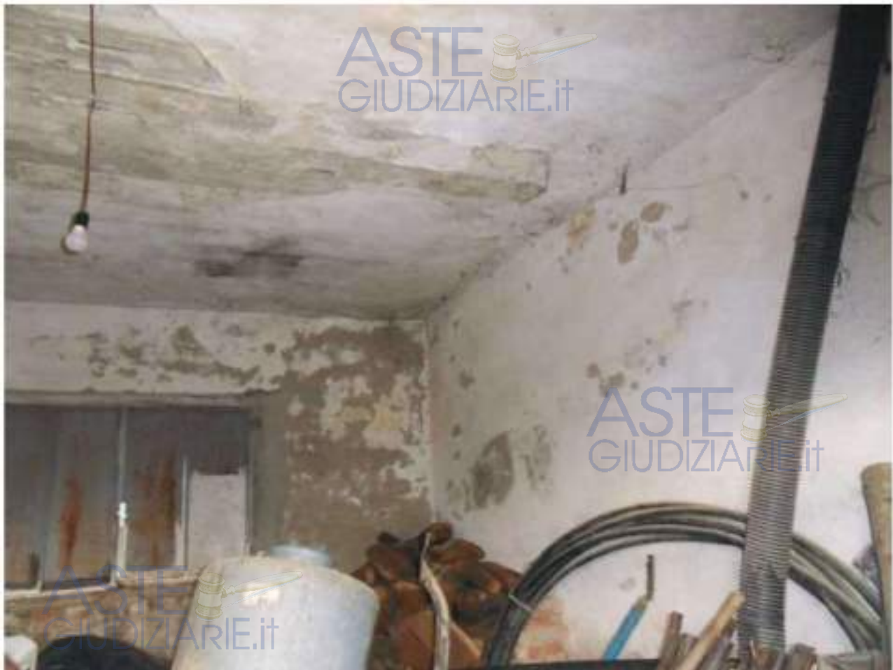
FOTO N. 126: Interni Bene N. 2
