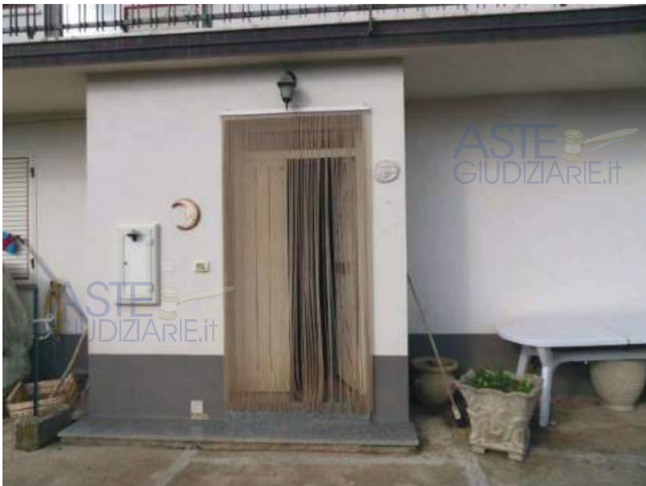
FOTO N. 11: Prospetto SUD - EST Bene N. 1 (Ingresso)
