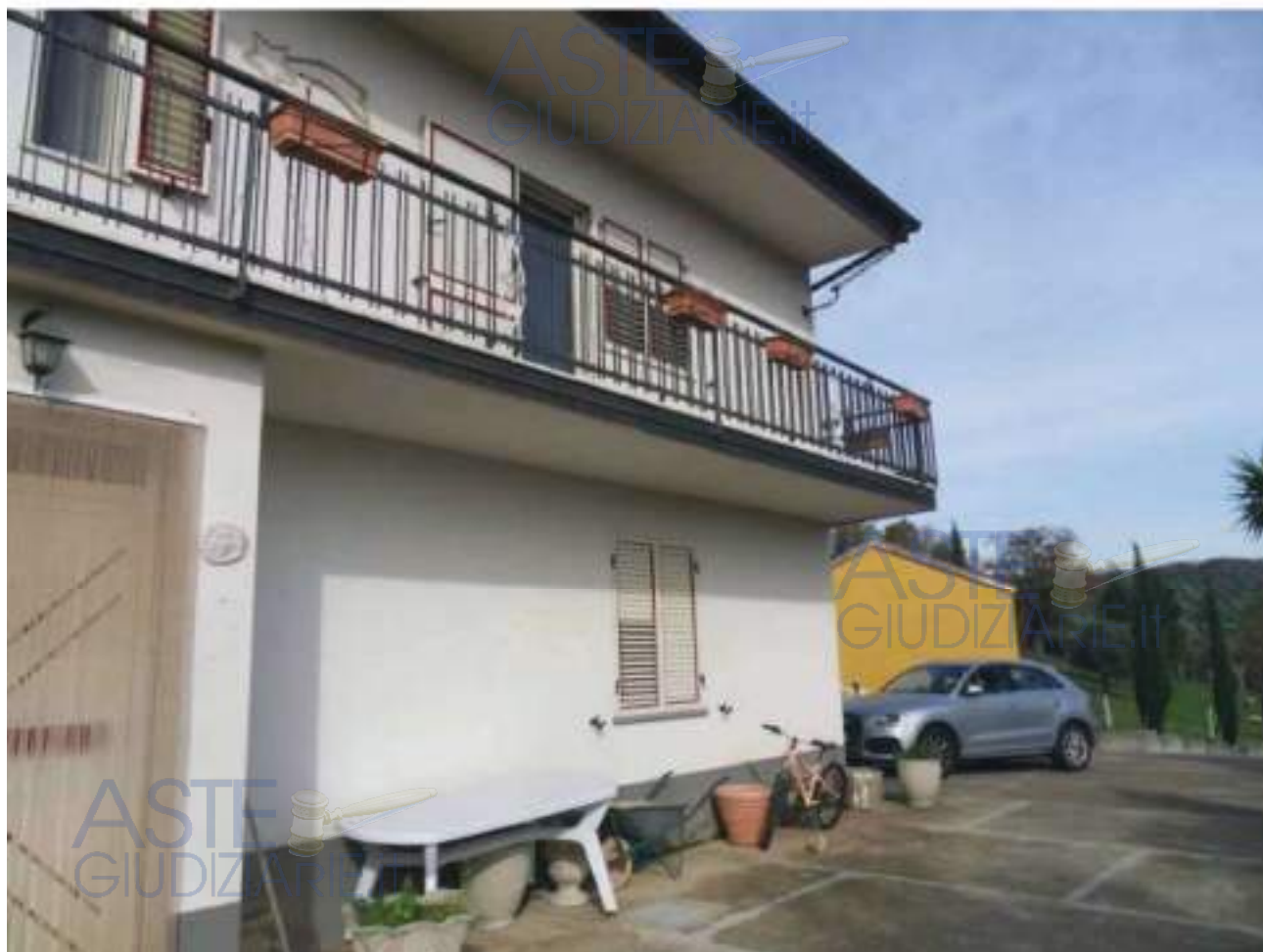
Publicazione ufficiale ad uso esclusivo personale - è vietata ogni ripubblicazione o riproduzione a scopo commerciale - Aut. Min. Giustizia PDG 21/07/2009 FOTO N. 6: Prospetto SUD - EST Bene N. 1
