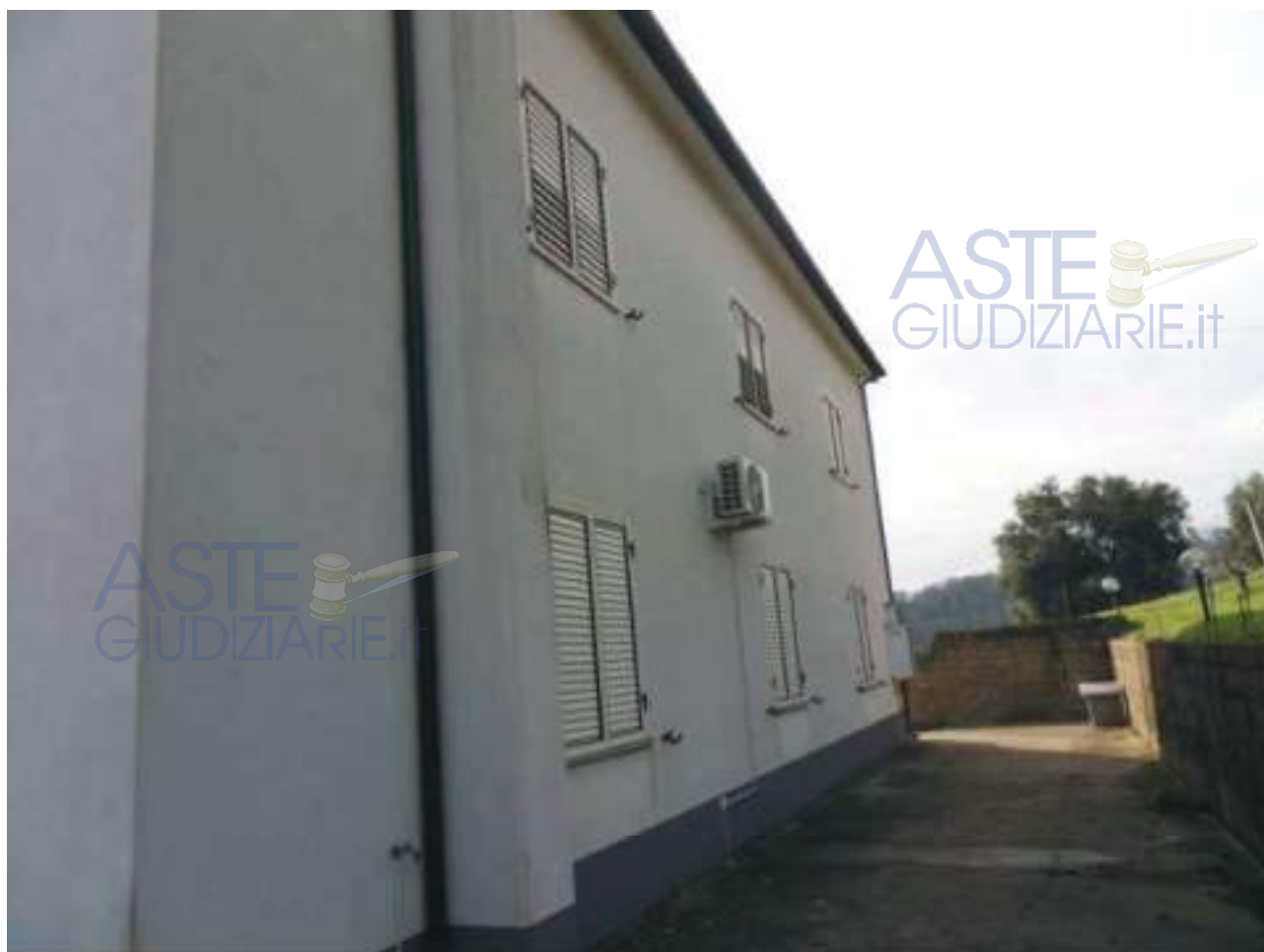
FOTO N. 13: Prospetto NORD - OVEST Bene N. 1
