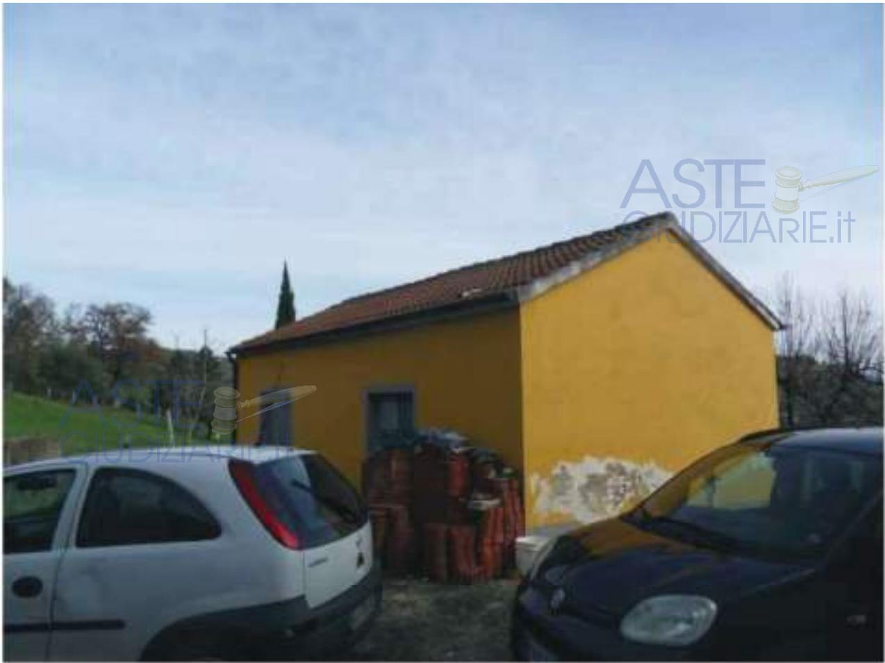
FOTO N. 121: Prospetto NORD – OVEST Bene N. 2
