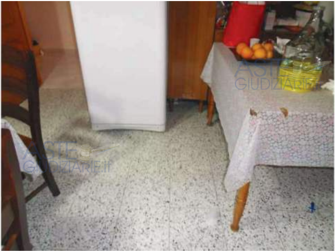
FOTO N. 23: Interni Bene N. 1 (PIANO TERRA)
