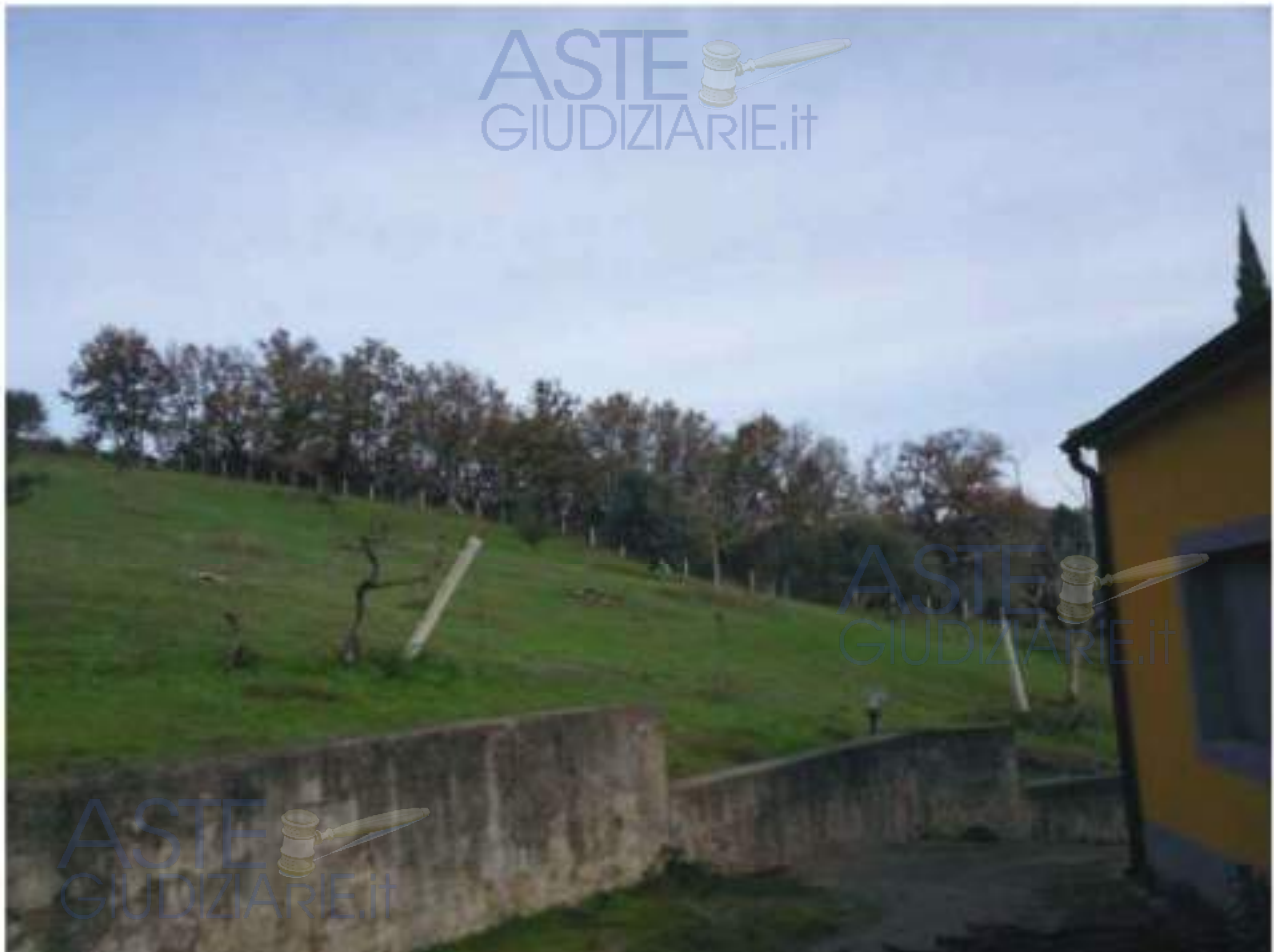
FOTO N. 162: Vista Bene N. 4 e N. 5 da Corte Bene N. 1
