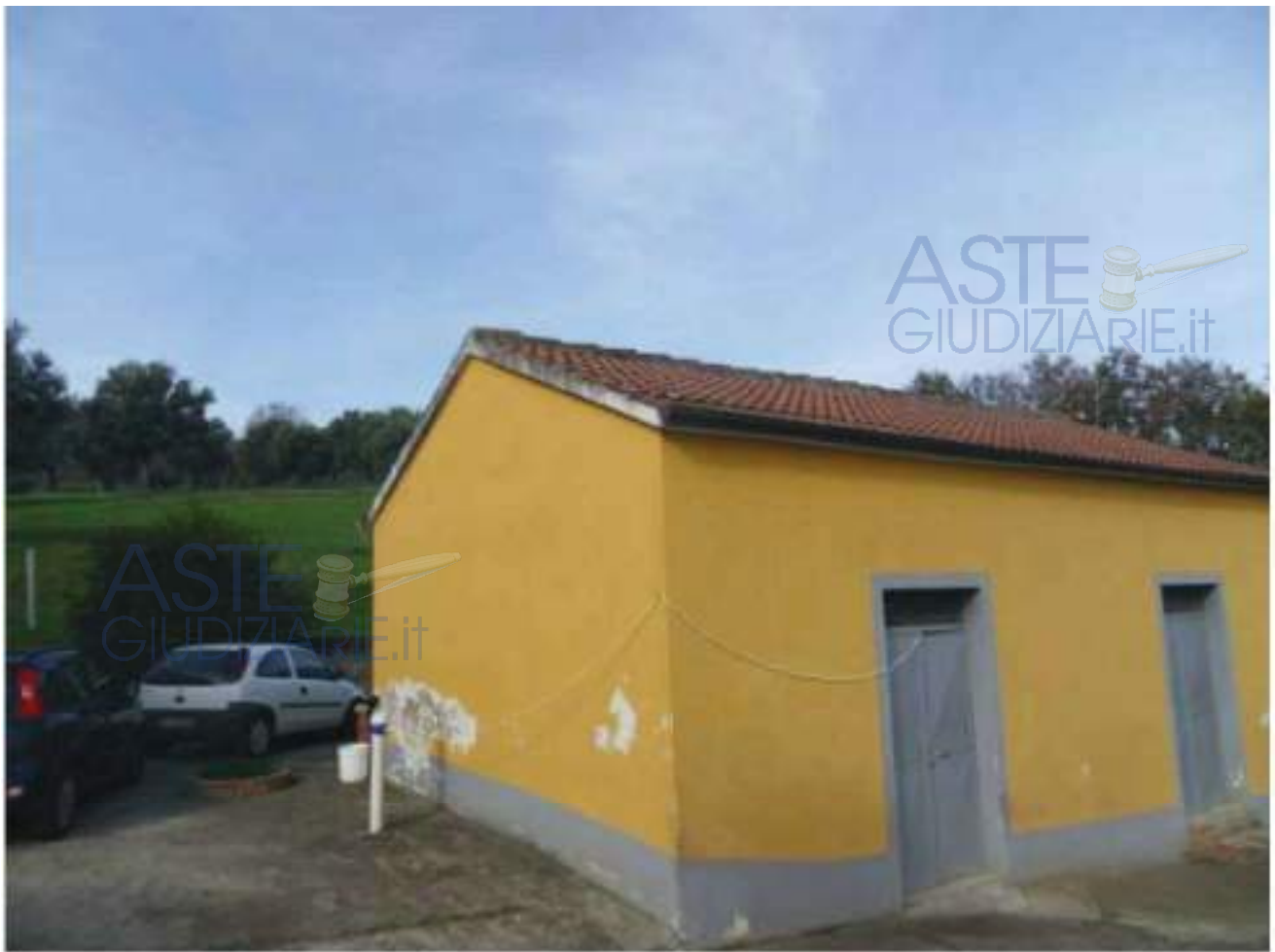
FOTO N. 119: Prospetto SUD - EST Bene N. 2
