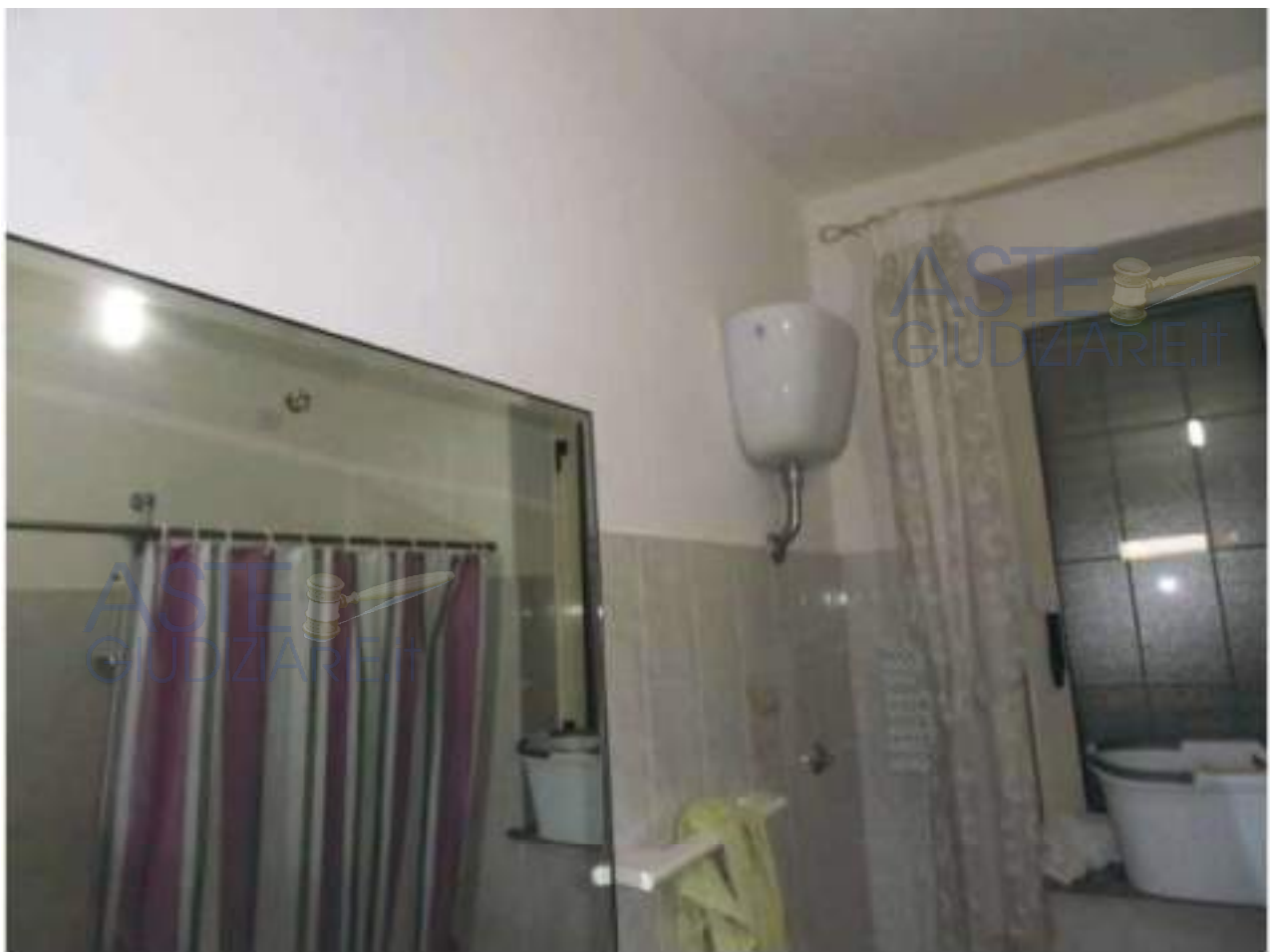
FOTO N. 55: Interni Bene N. 1 (PIANO TERRA)
