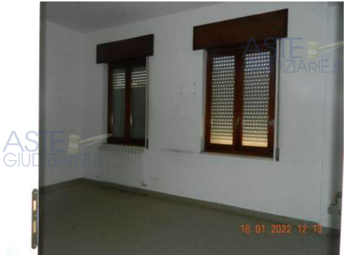
Piano terra – vano
