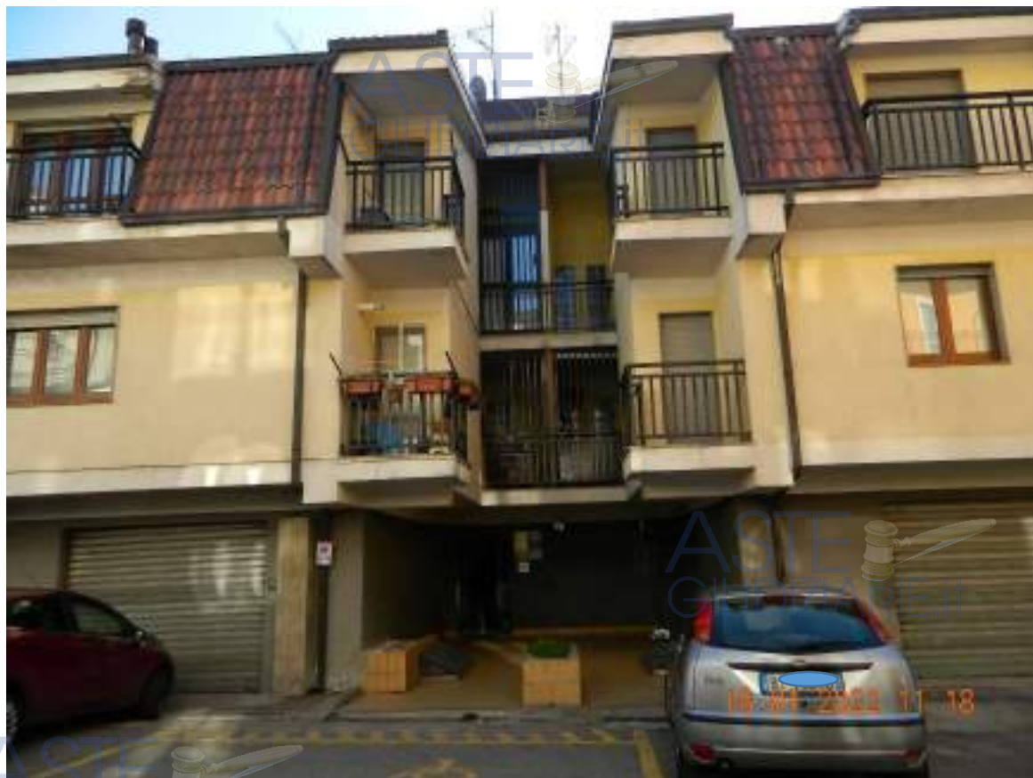
Ingresso al vano scala condominiale
