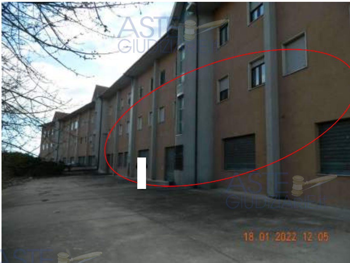
Accesso all'unità immobiliare attraverso la corte esclusiva.
