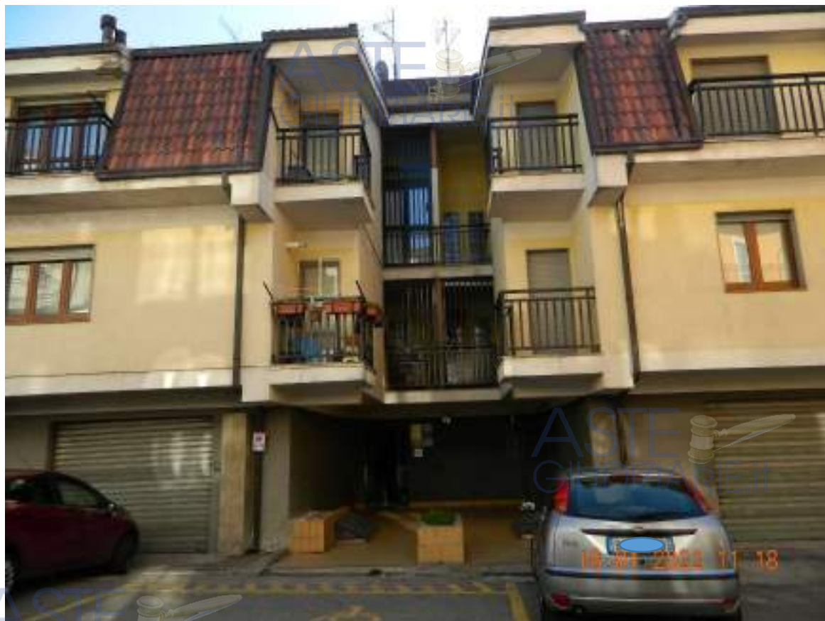
Ingresso al vano scala condominiale
