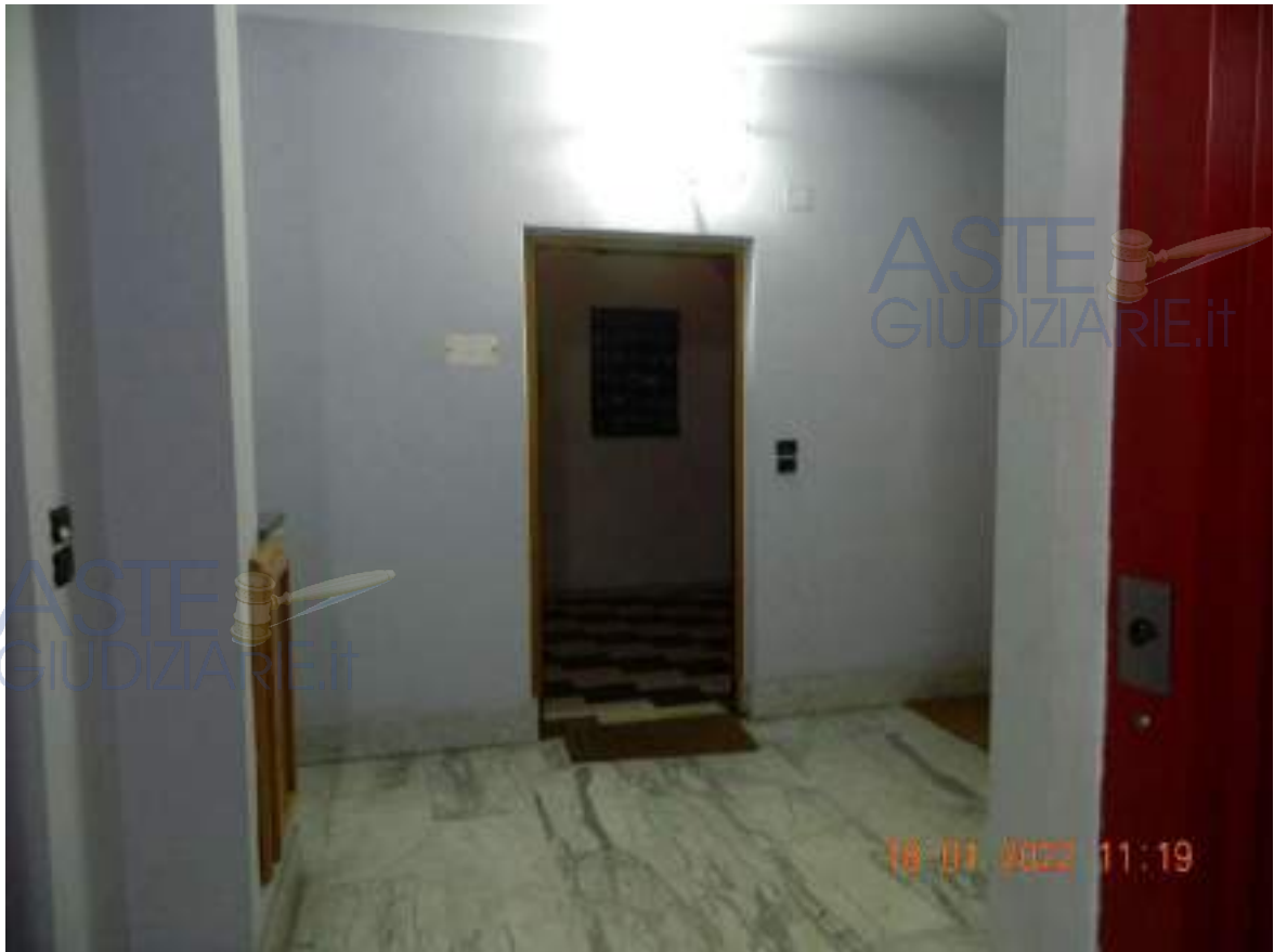
Ingresso su pianerottolo condominiale
