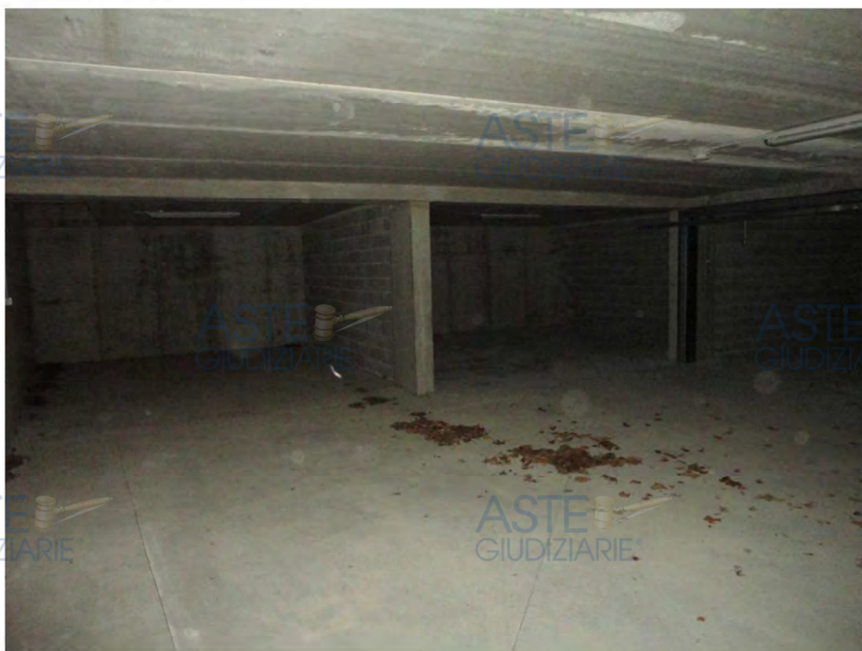
Residenza Argentera - Autorimessa
