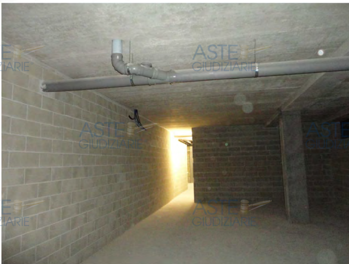
Residenza Belvedere - interno magazzino
