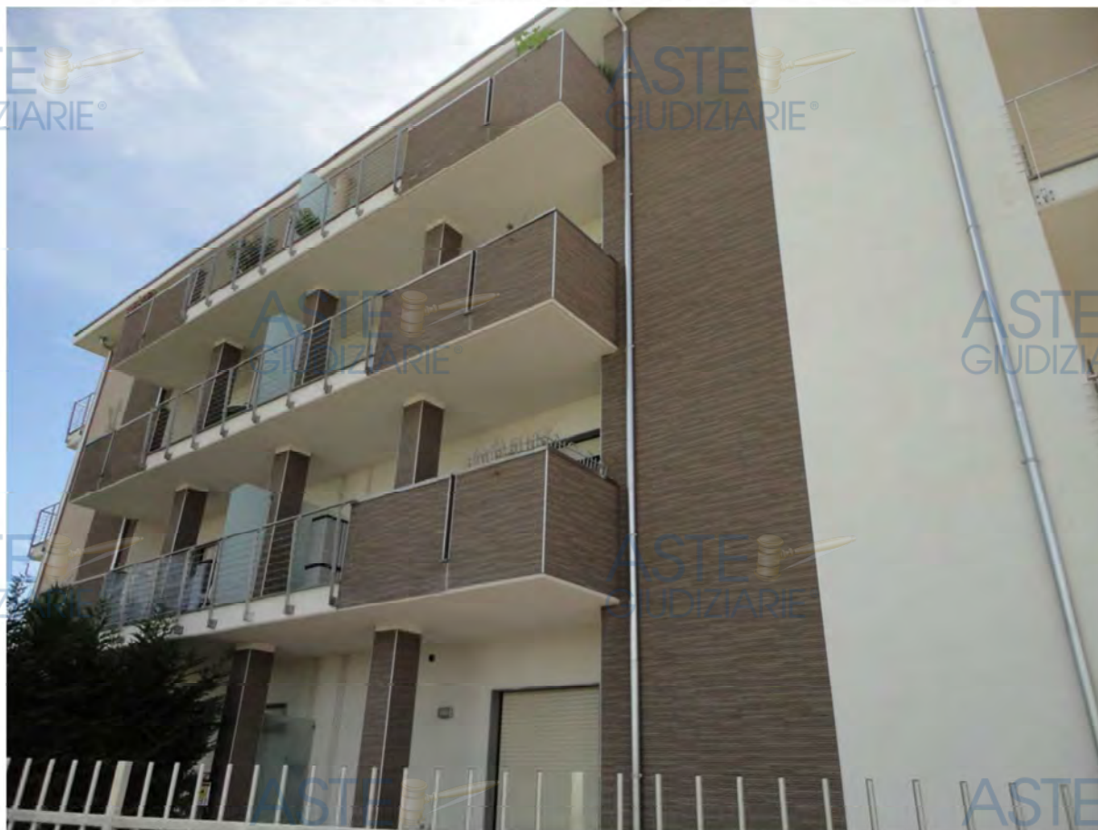
Residenza Belvedere - esterno
