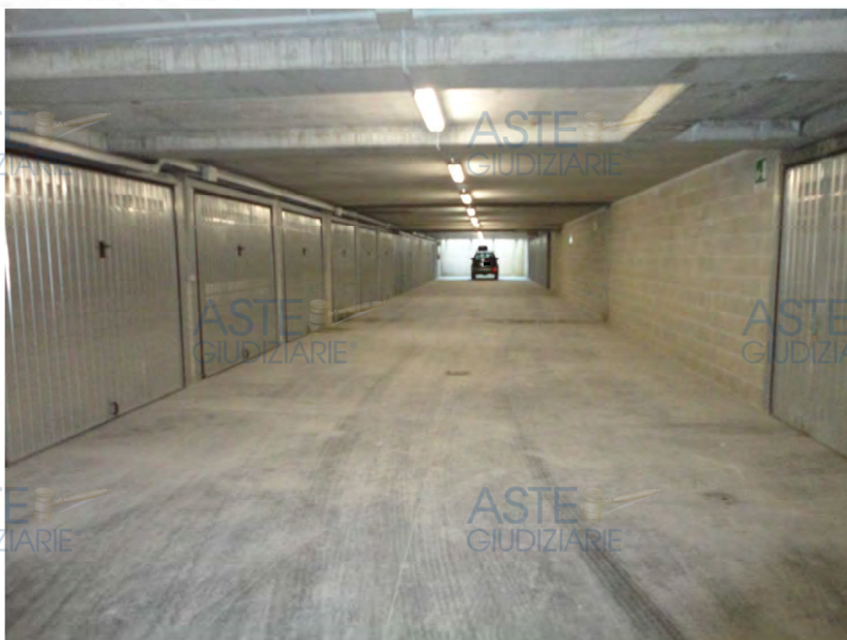
Residenza Maneggio - Autorimesse
