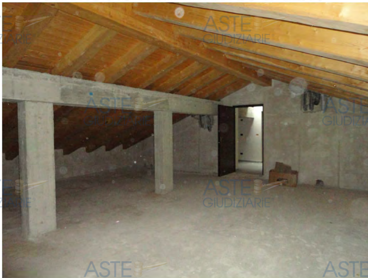
Residenza Argentera - interno sottotetto
