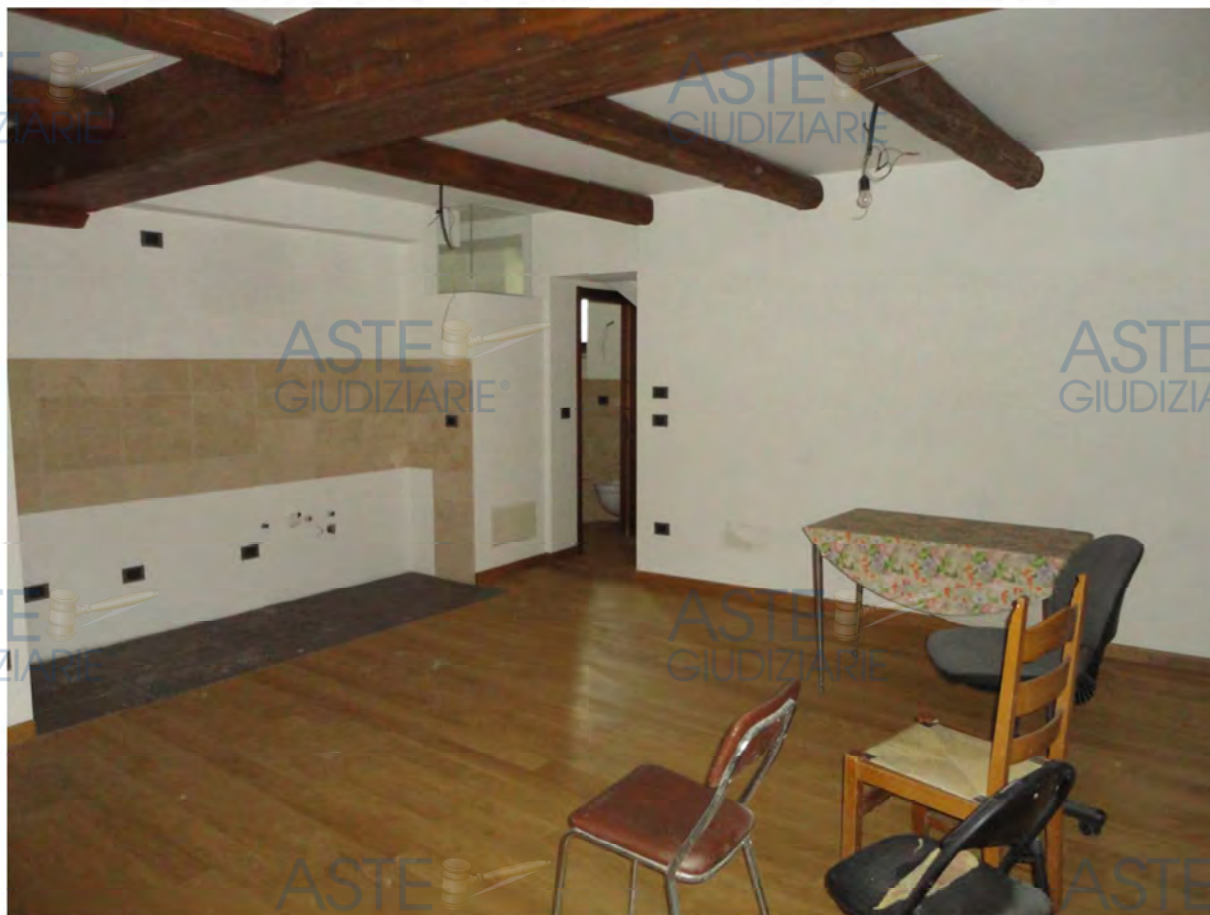
Residenza Casa et Re - interni
