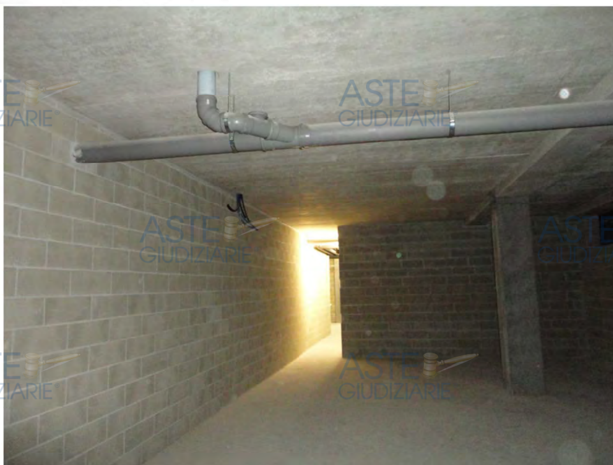
Residenza Belvedere - interno magazzino
