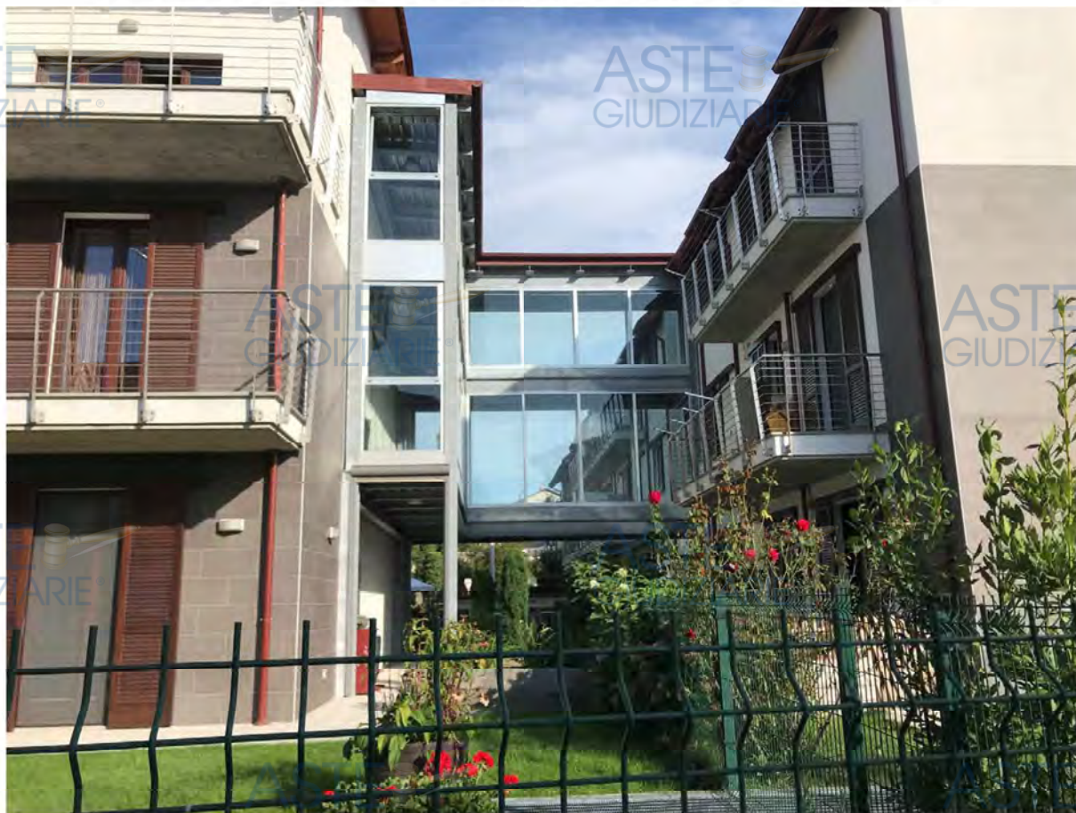
Residenza Maneggio - esterno
