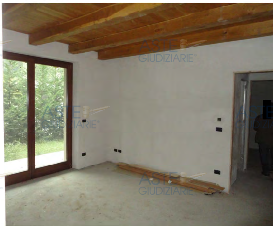
Residenza Argentera - interno alloggi
