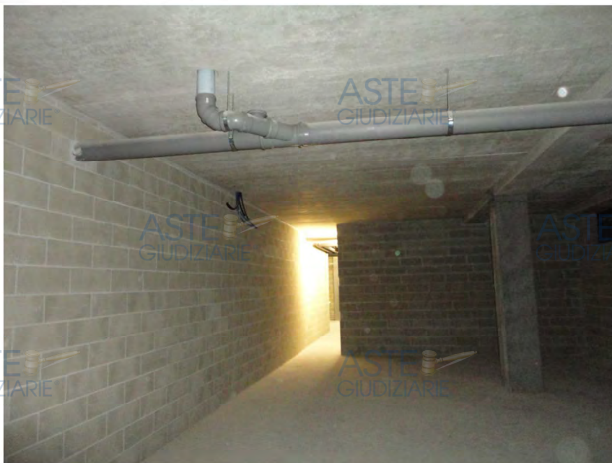
Residenza Belvedere - interno magazzino
