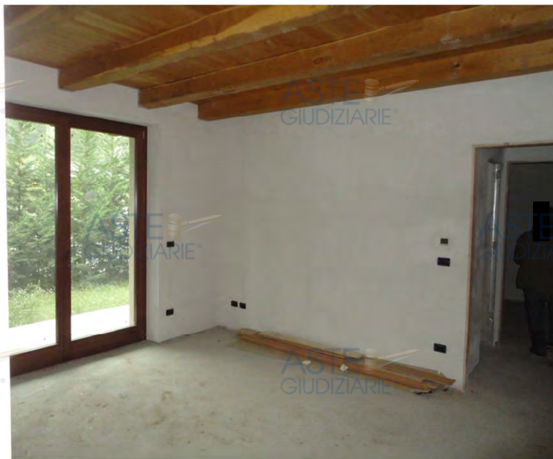
Residenza Argentera - interno alloggi
