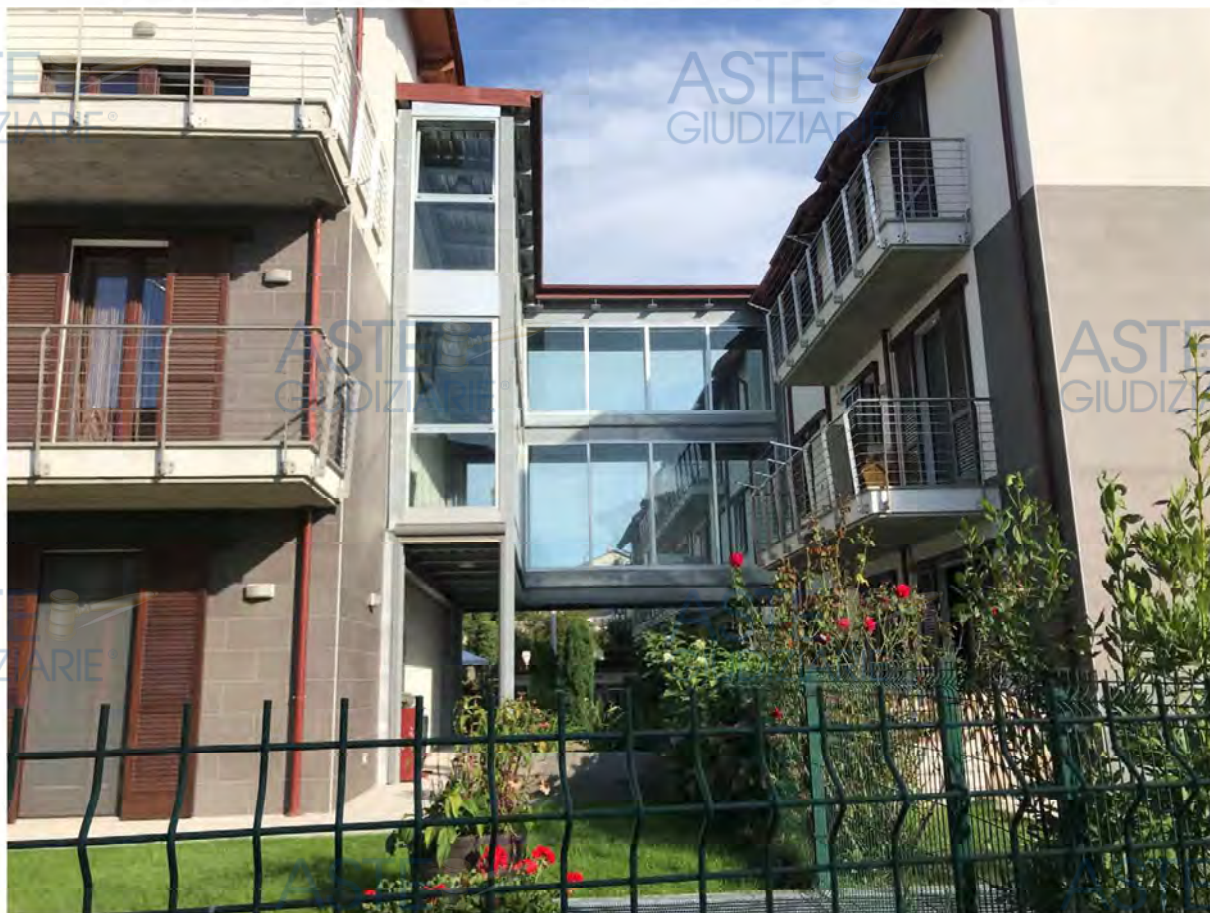
Residenza Maneggio - esterno
