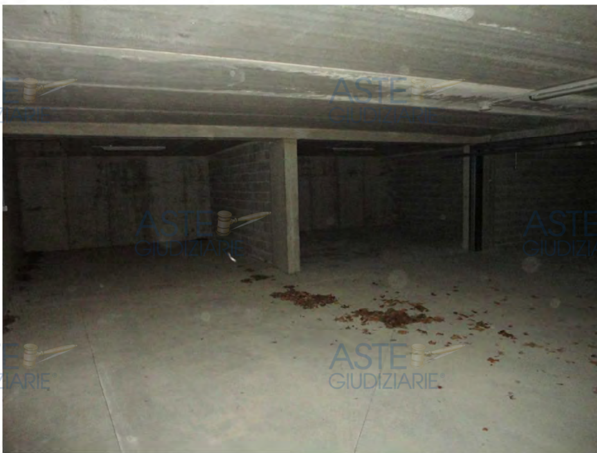
Residenza Argentera - Autorimessa
