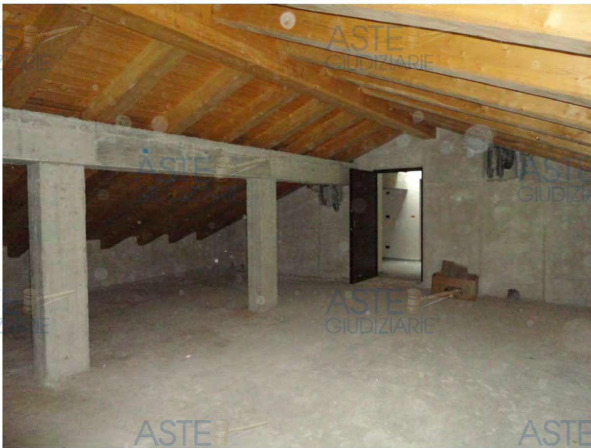
Residenza Argentera - interno sottotetto
