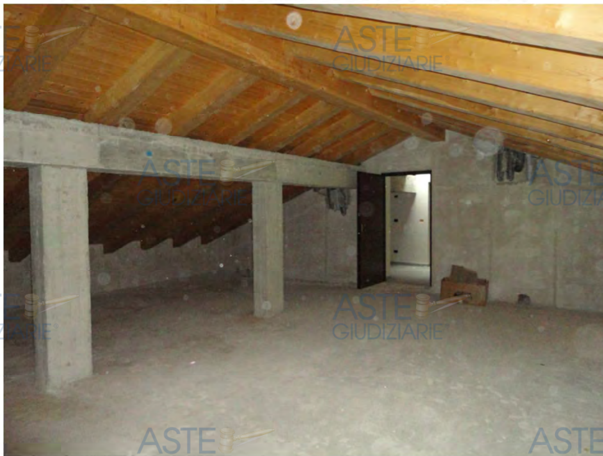
Residenza Argentera - interno sottotetto
