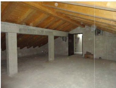
Residenza Argentera – interno sottotetto
