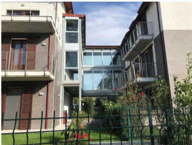
Residenza Maneggio - esterno
