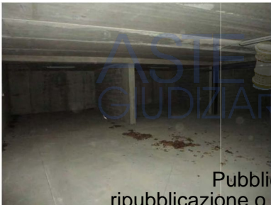
Residenza Argentera – Autorimessa
