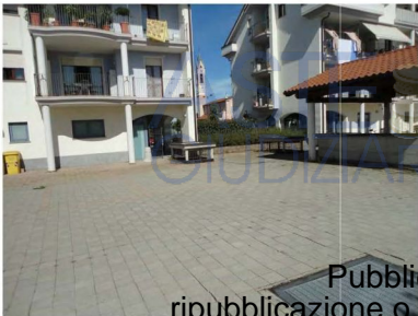
Residenza Girasole – posti auto esterni e vista aiuola posta tra i due condomini
