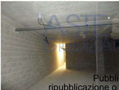
Residenza Belvedere - interno magazzino
