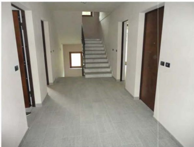
Residenza Argentera – vano scala
