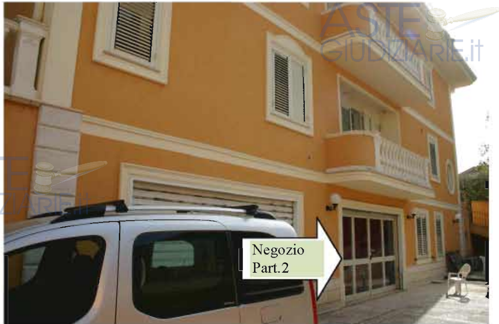
Foto 8 ingresso piano seminterrato , Villa indipendente piano terra e primo Fg. 7 part. 1995 sub 2-3 -4 Comune di Montedoro (CL)
