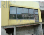
Foto n. 4 rampa e accesso
