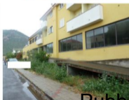
Foto n. 6 rampa e accesso
