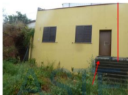
Foto n. 1 prospetto parte separata
