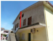
Foto n 4 prospetto interno
