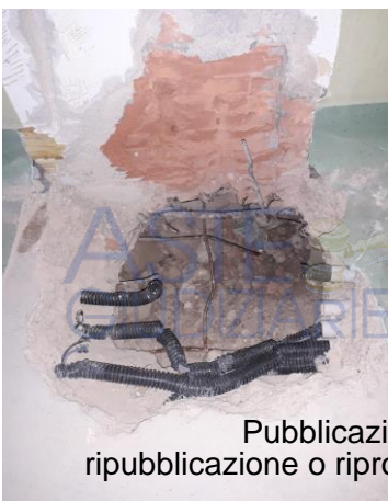
FOTO 14 – A1 - lato corridoio 2
