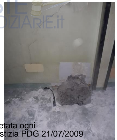
Foto 15 – L7 - A1 - corridoio 2
