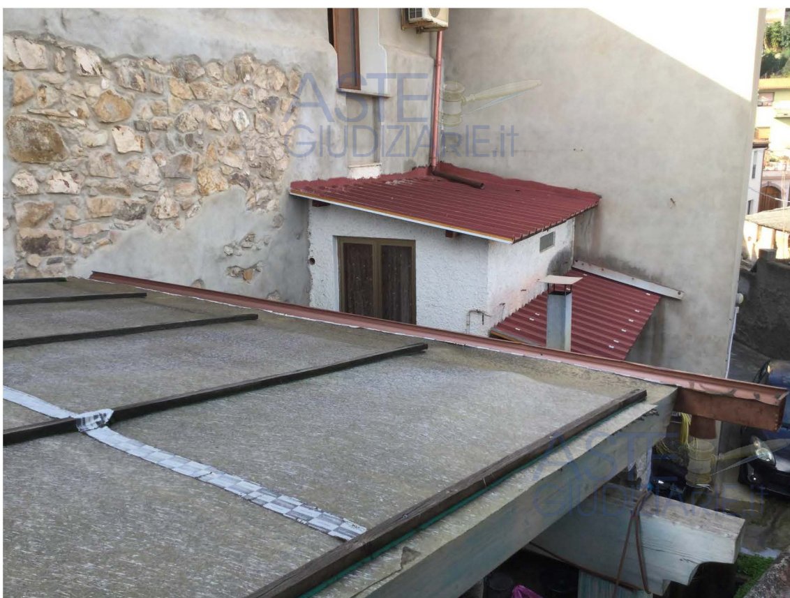
Particolari delle coperture
