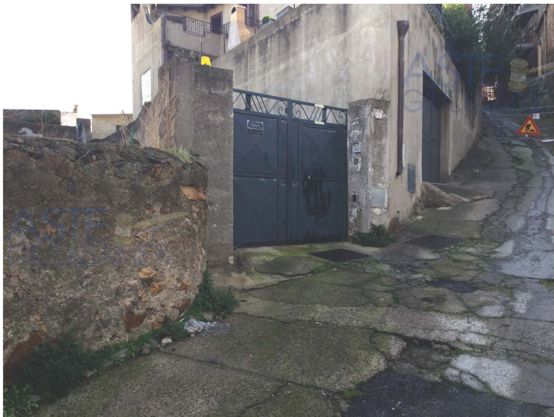
Vista del fabbricato dalla Via Carlo Alberto
