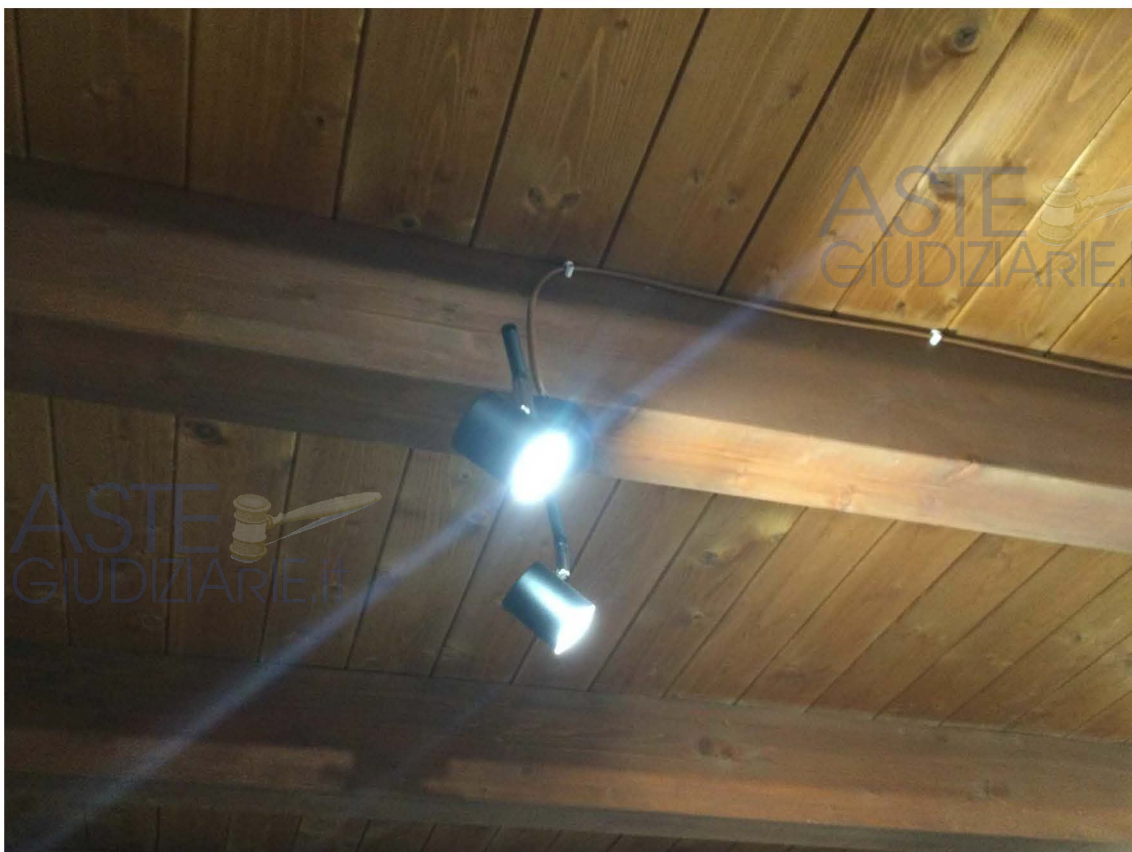
Copertura del piano terra e dettaglio dell'illuminazione
