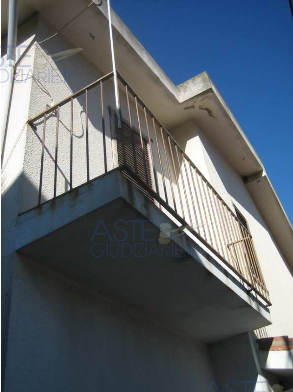
foto 3: esterno prospetto laterale e balcone
