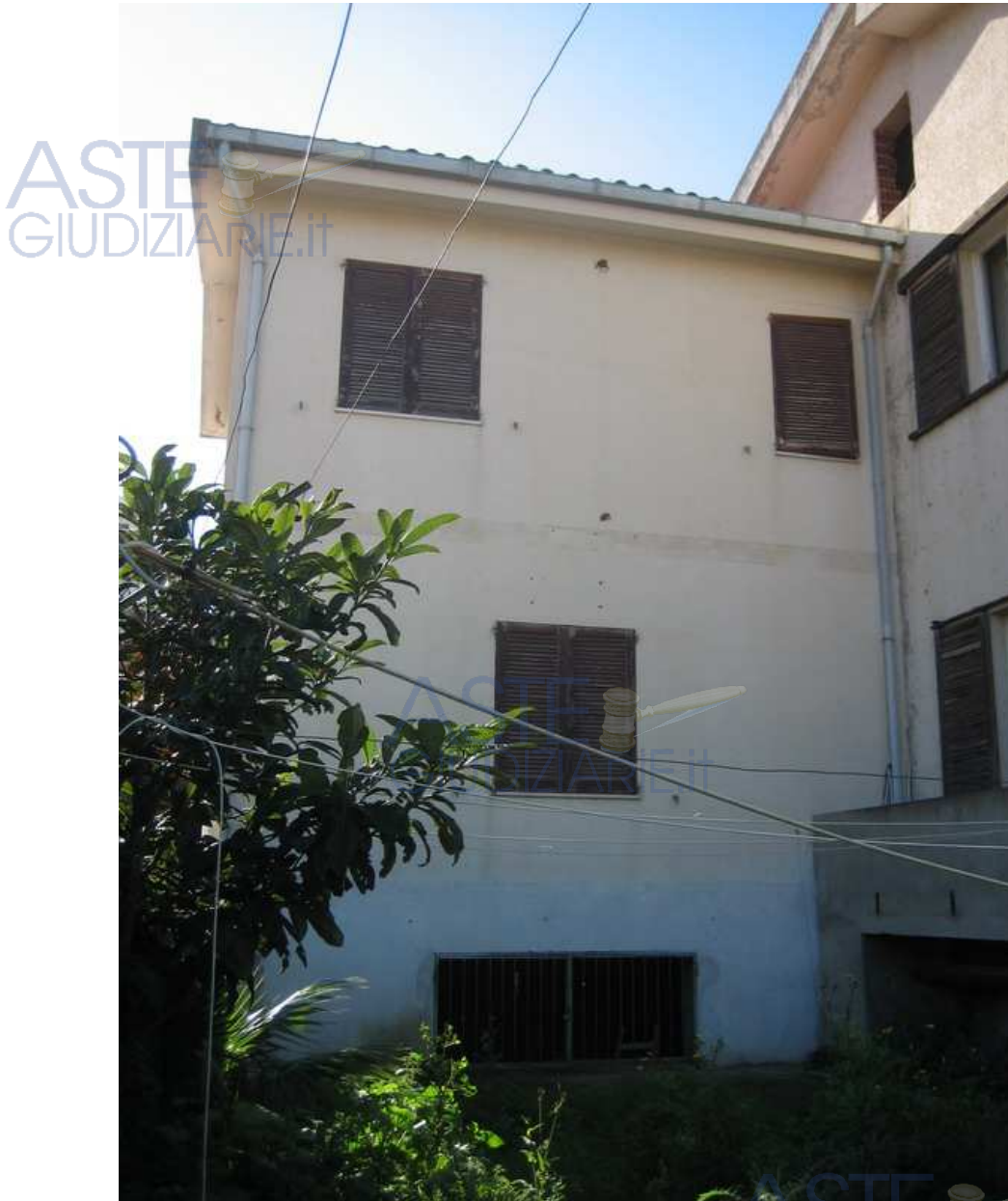
foto 2: esterno prospetto secondario
