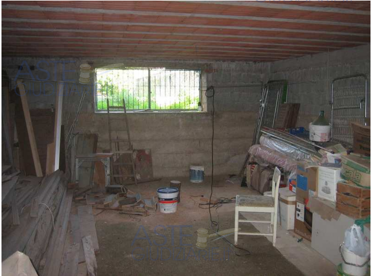
foto 15: interno piano interrato: locale cantina
