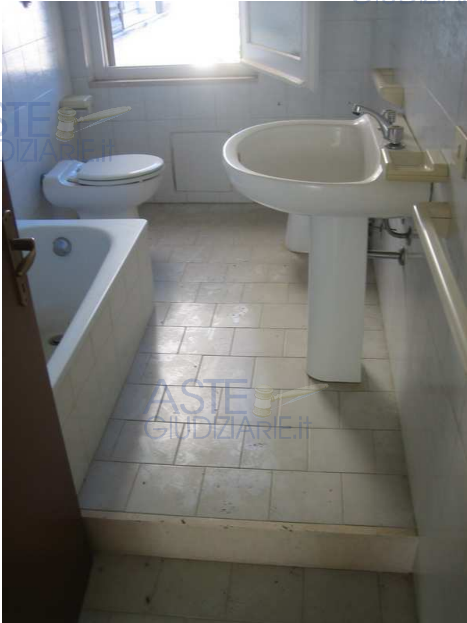
foto 14: interno piano primo: bagno
