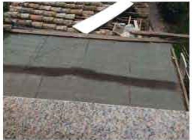
Figura 21. Copertura locale di sgombero 1
