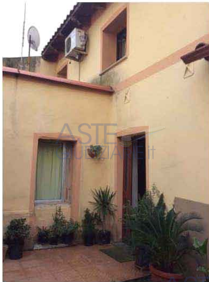
Figura 12. Vista dal cortile interno del prospetto anteriore
