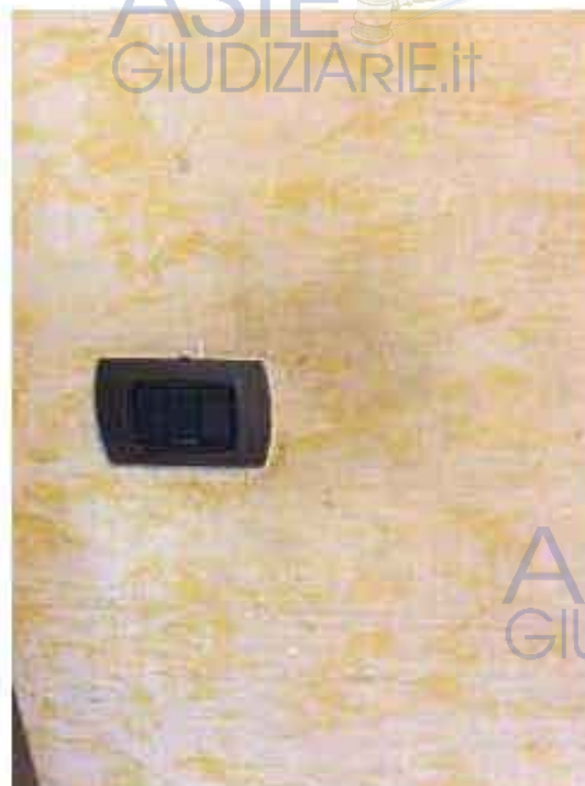
Figura 45. Particolare parete spugnata
