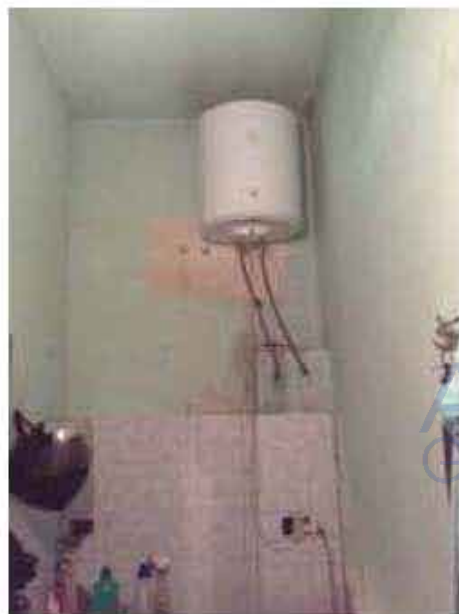
Figura 48. Boiler elettrico
