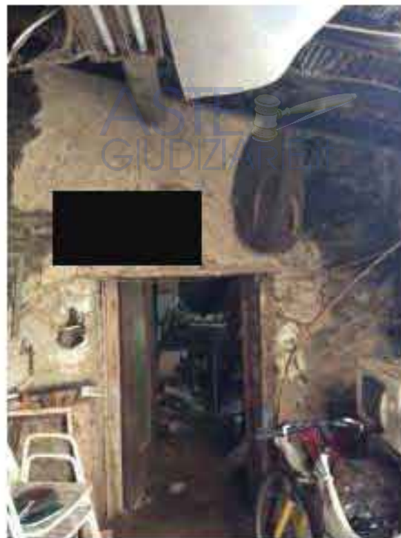
Figura 22. Veduta locale di sgombero 2
