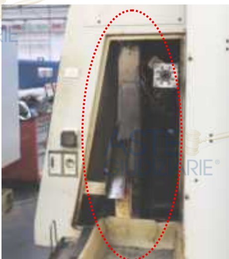
Ripari fissi zone laterali dei torni rimosse e non riposizionate
