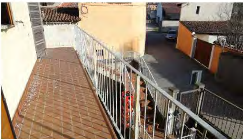
FOTOGRAFIA - N. 13 L'ACCESSO TRAMITE SCALA ESTERNA E BALCONE AL PIANO PRIMO E SECONDO
