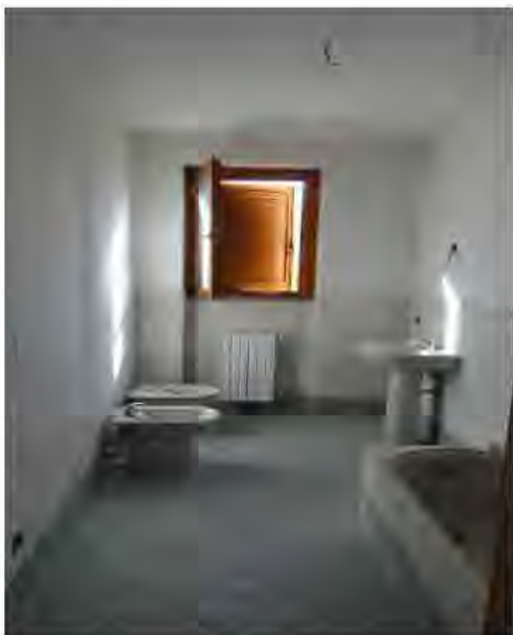
FOTOGRAFIA - N. 20 SERVIZIO IGIENICO PIANO PRIMO
