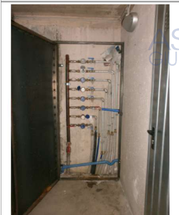
N. 51 - Dettaglio quadro contatori acqua.
