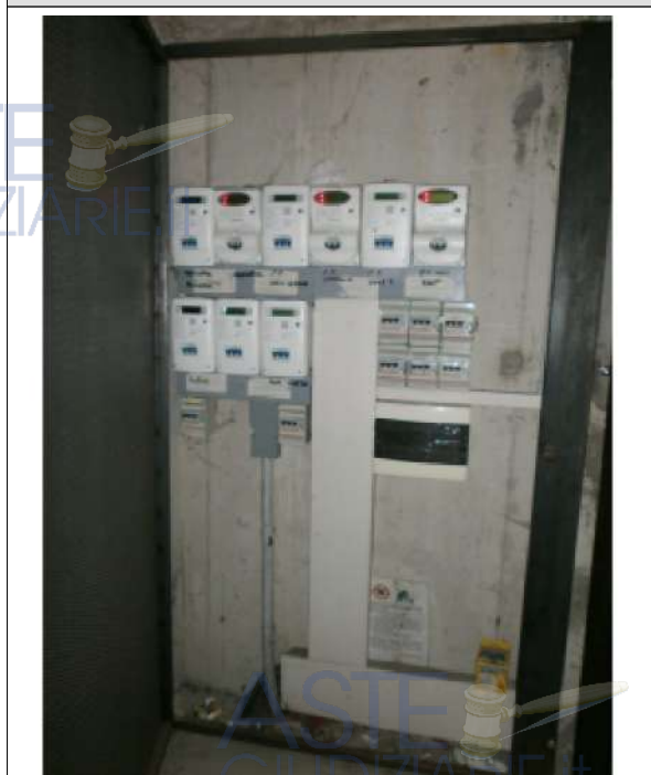
N. 52 - Dettaglio quadro contatori elettrici.
