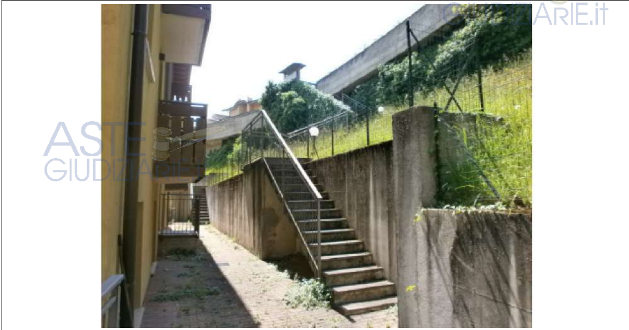
N. 11 - Vista scala di ingresso principale, lato ovest.
