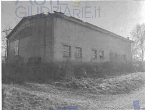
14 – Esterno del fabbricato ad uso magazzino
