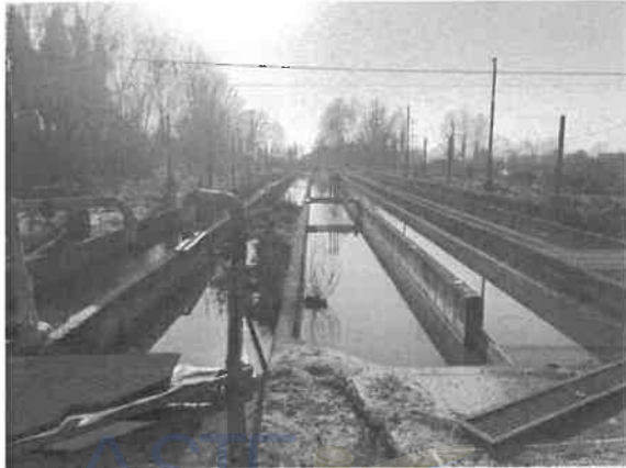
43 - vasche esterne ad uso avannotteria
