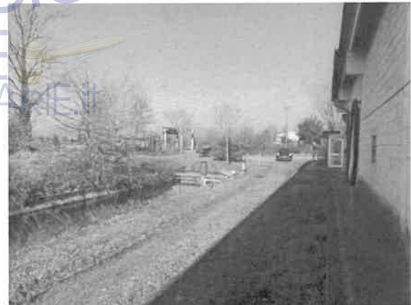
30 – Esterno del fabbricato ad uso avannotteria
