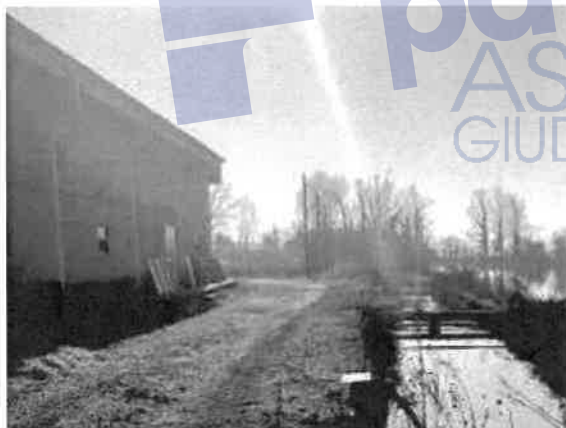
29 – Esterno del fabbricato ad uso avannotteria
