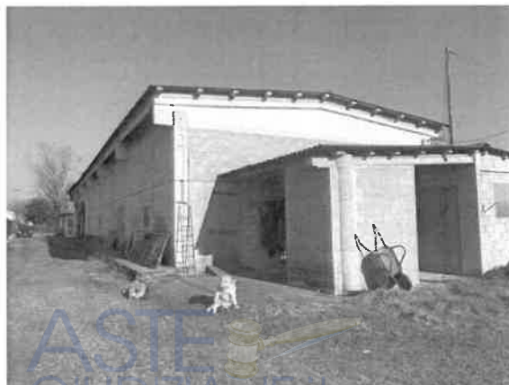
31 – Esterno del fabbricato ad uso avannotteria
