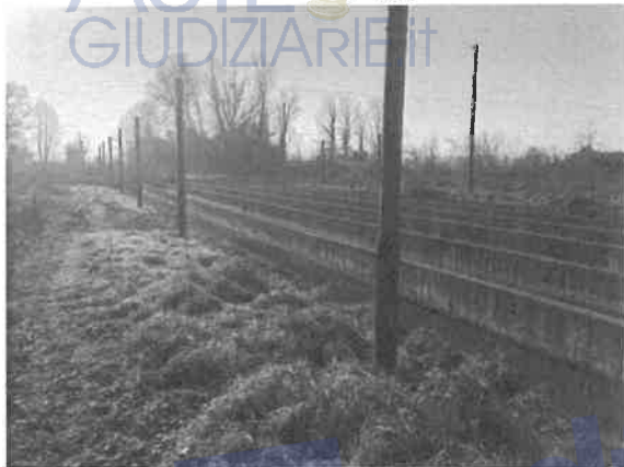
45 - vasche esterne ad uso avannotteria
