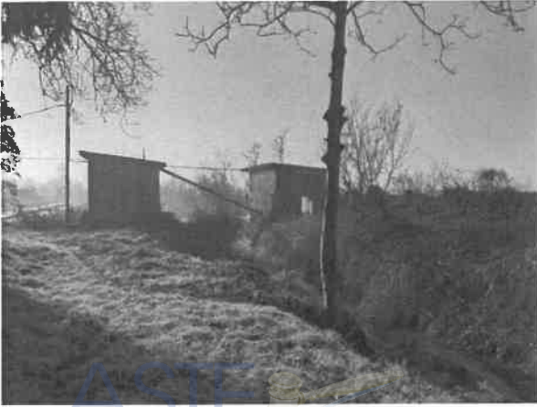
7- Manufatti per pompe
