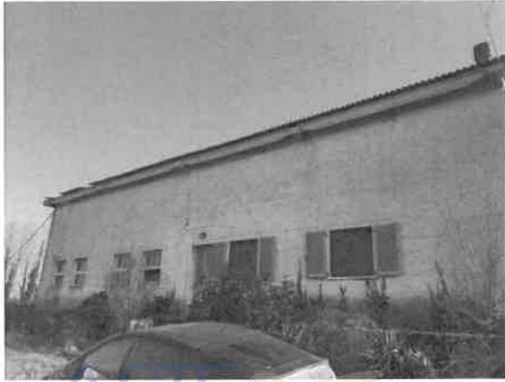
13 – Esterno del fabbricato ad uso magazzino
