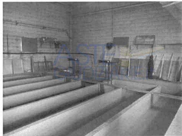
42 - interno del fabbricato ad uso avannotteria
