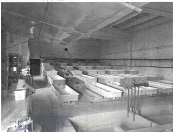
41 - interno del fabbricato ad uso avannotteria
