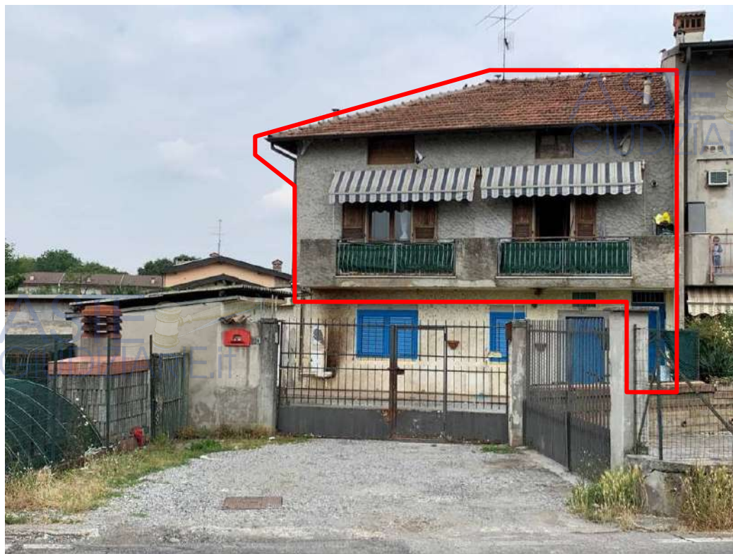
Fig. 04: Individuazione dell'immobile oggetto di perizia (prospetto Sud)
