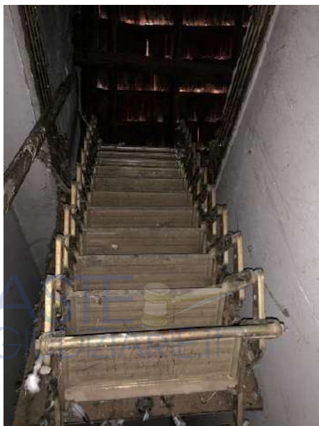
Figura 22: Vista della scala retrattile di accesso al sottotetto
