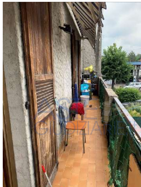
Figura 21: Vista del balcone
