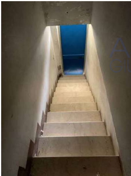
Figura 14: Vista dal piano primo del vano scala di ingresso
