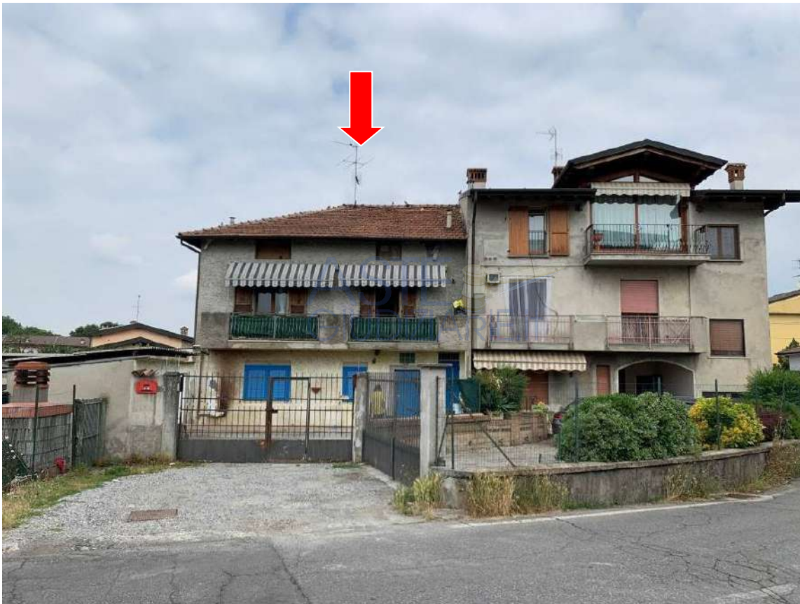
Fig. 03: Vista dell'edificio da via Civate (prospetto Sud)
