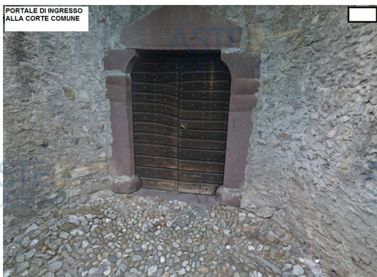
Fotografia n. 33 – Portale di Ingresso verso Corte Comune Lato Sud
