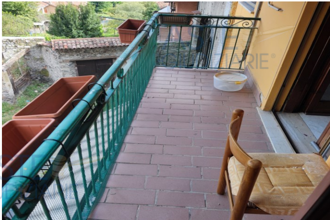
Fotografia n. 20 – Terrazza che dalla Camera conduce al Locale Caldaia
