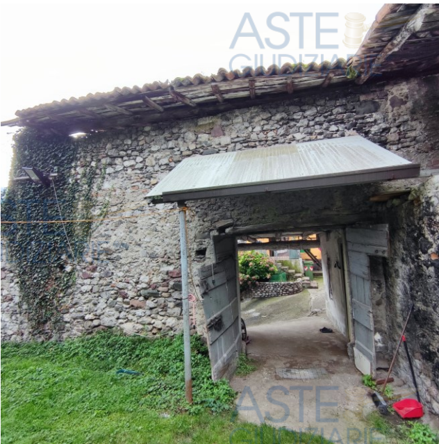
Fotografia n. 32 - Corpo Esterno- Particolare Vista Nord
