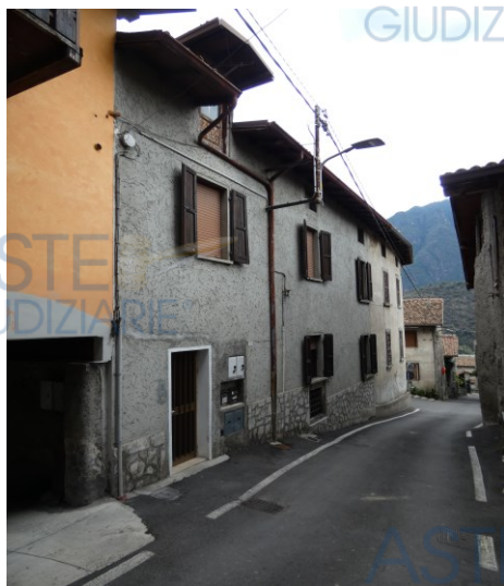
Fotografia n. 1 –Ingresso Posto sul fronte Sud- Via G.Rossini- Civico n. 2
