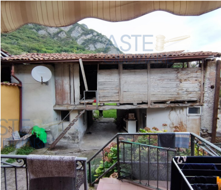
Fotografia n. 29- Corpo Esterno- Ripostiglio su due Piani
