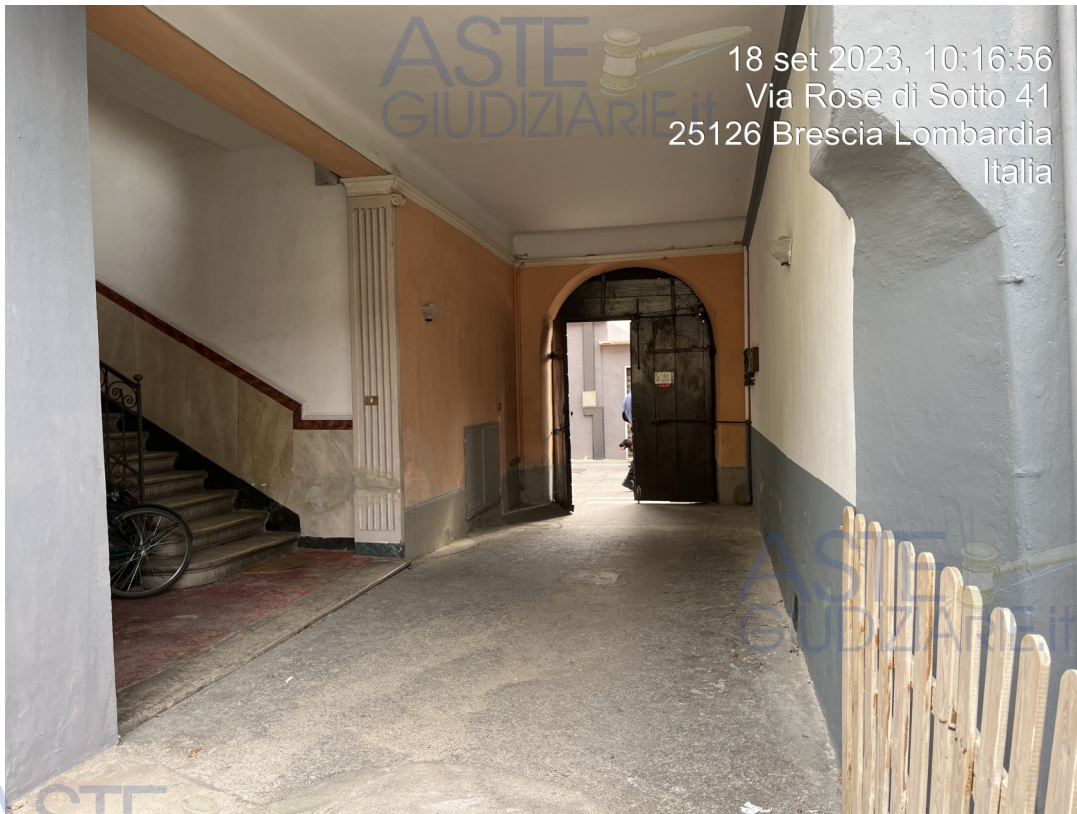
Fotografia 2 – Vista androne comune d’ingresso
