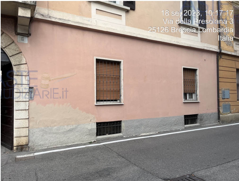
Fotografia 1 – Vista del fronte est dell’immobile su Via della Presolana
