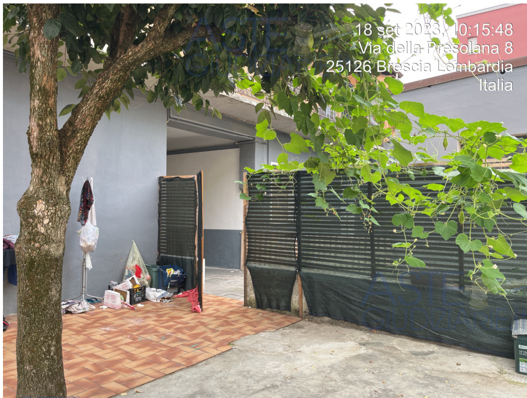
Fotografia 4 – Vista ingresso corte comune attualmente utilizzata ad uso personale verso androne comune d’ingresso
