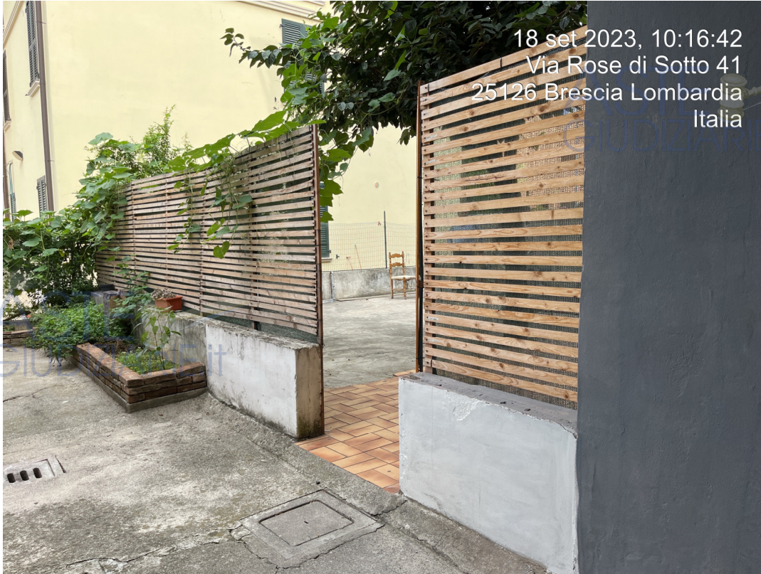
Fotografia 3 – Vista ingresso corte comune attualmente utilizzata ad uso personale da androne comune d’ingresso
