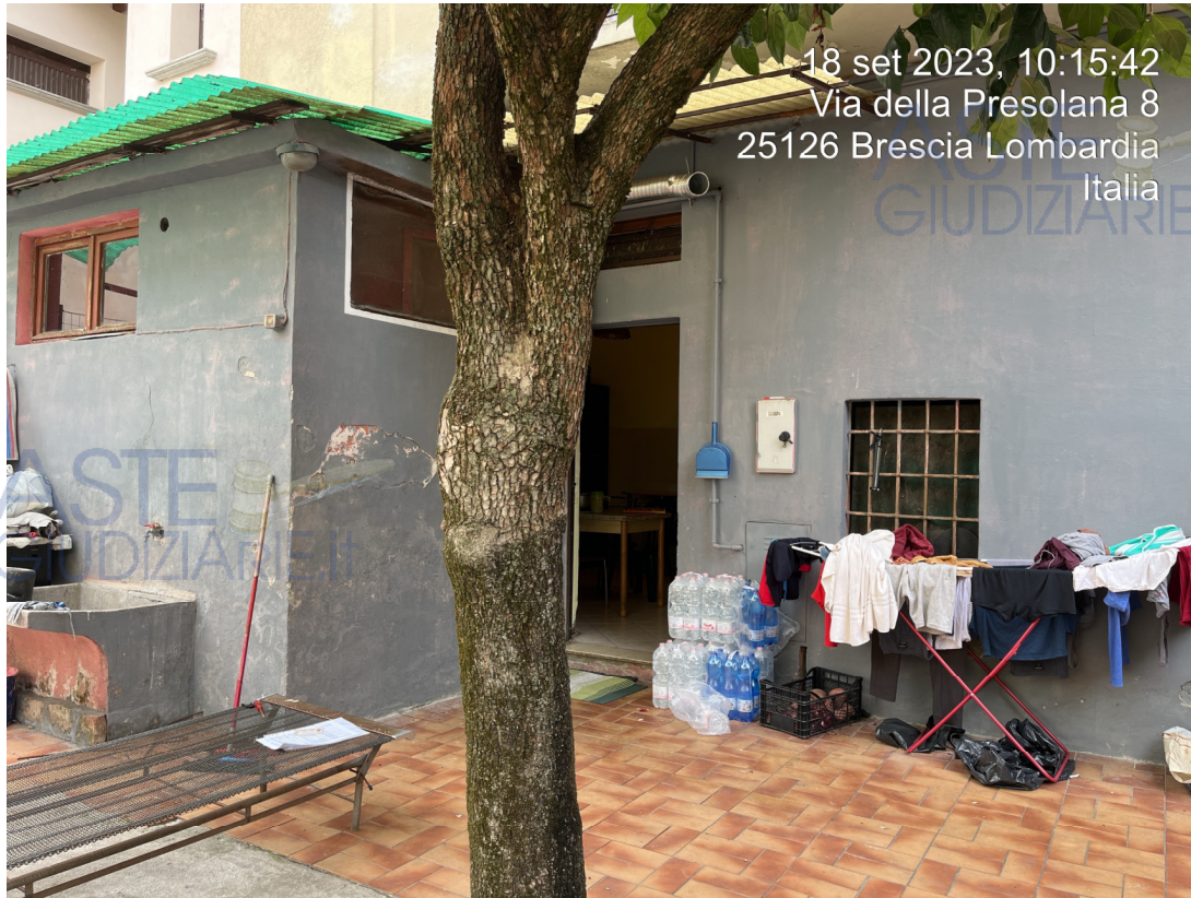
Fotografia 5 – Vista dell’ingresso all’unità immobiliare e della latrina comune utilizzata ad uso personale da corte comune utilizzata anch’essa ad uso personale
