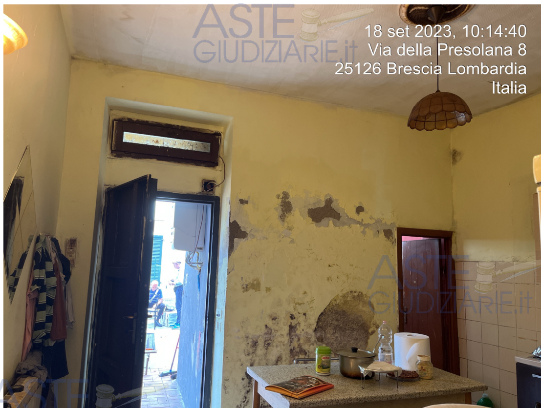
Fotografia 6 – Vista zona giorno con porta di accesso alla latrina comune
