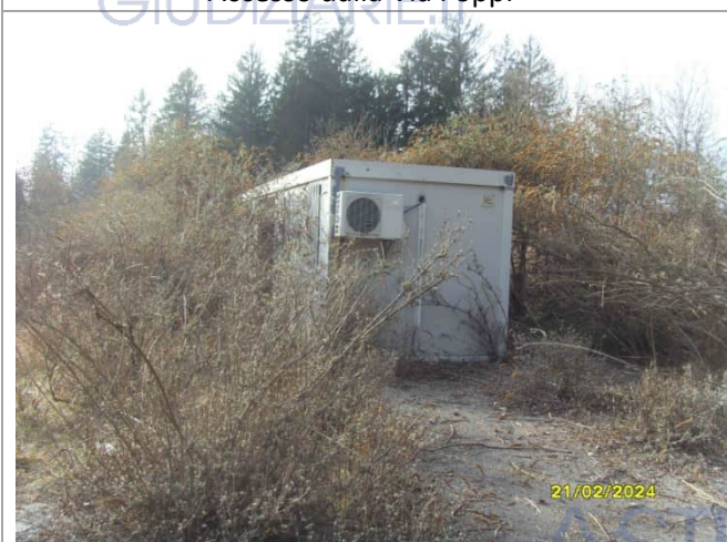
Container di cantiere – zona nord
