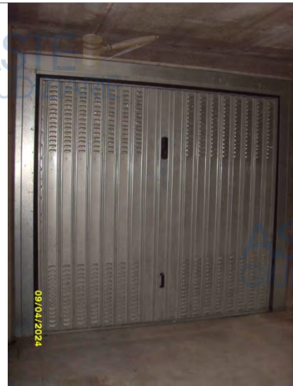
Autorimessa – p.lla 8760 sub 30
