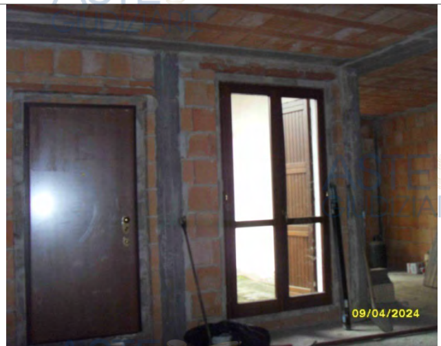
Interno Piano Terra
