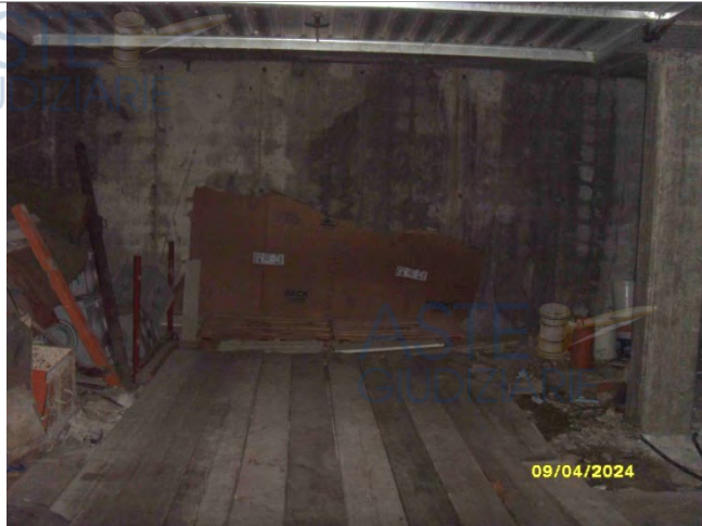
Piano Interrato in corso di costruzione
