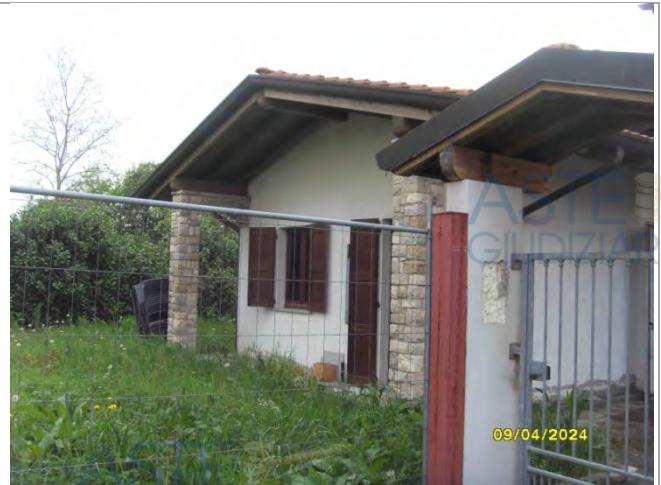
Villetta di testa in corso di costruzione
