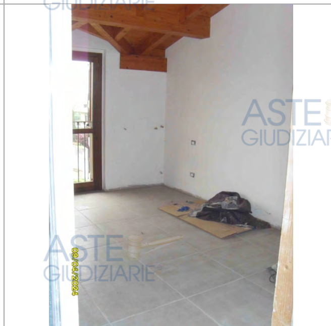
Sottotetto da recuperare in corso di costruzione
