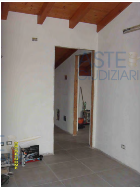
Sottotetto da recuperare in corso di costruzione
