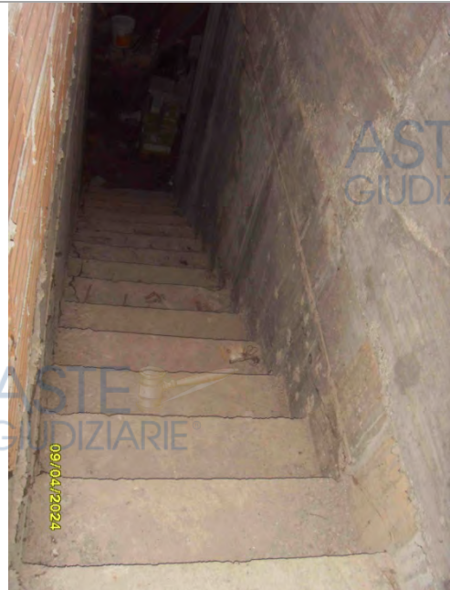
Scala di accesso al piano Interrato
