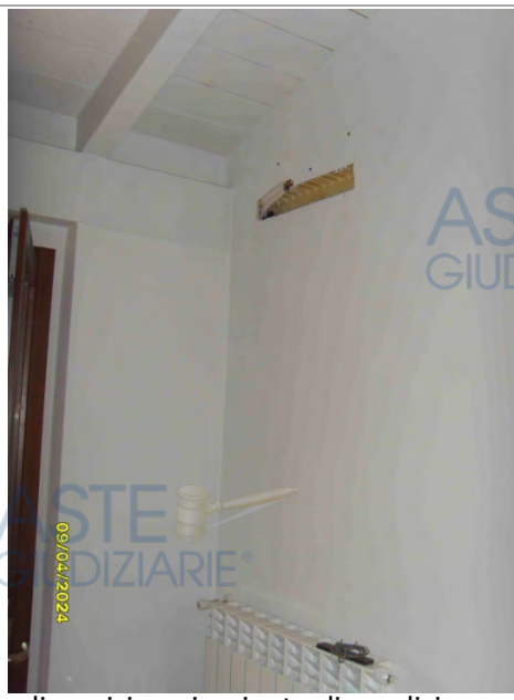
Predisposizione impianto di condizionamento
