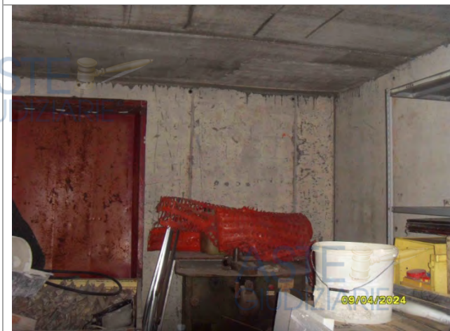
Autorimessa in corso di costruzione
