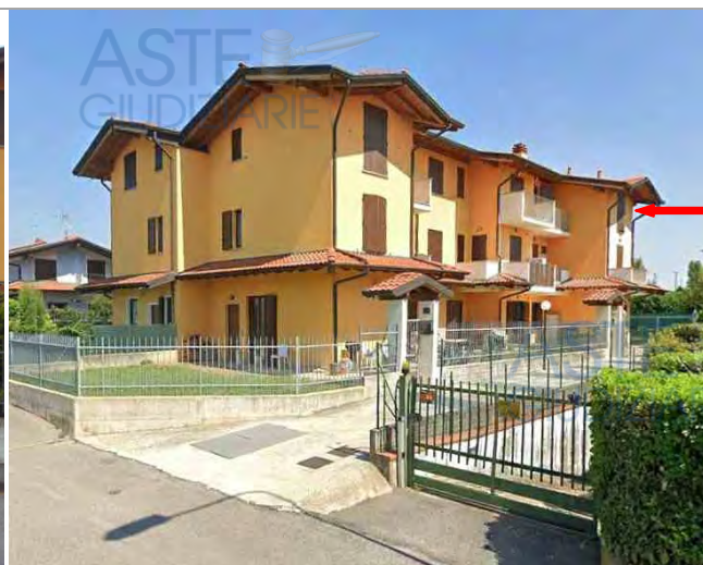
Sottotetto P. 2° - p.lla 8760 sub 744
