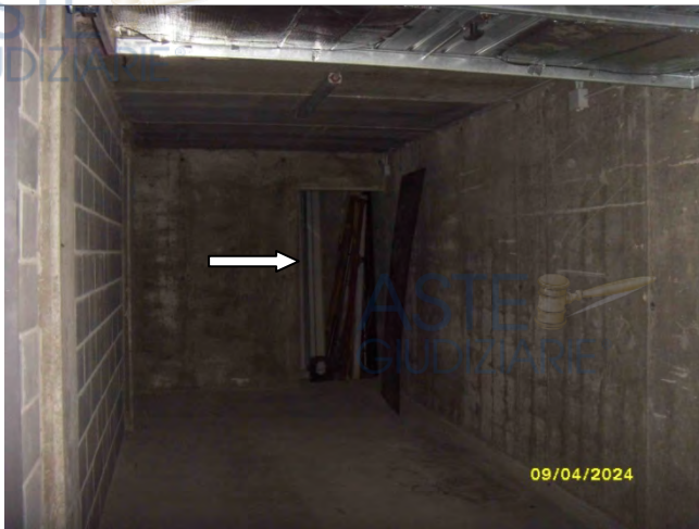
Autorimessa – p.lla 8760 sub 740 e cavedio
