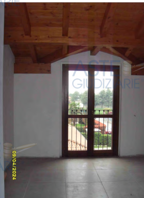
Sottotetto da recuperare in corso di costruzione
