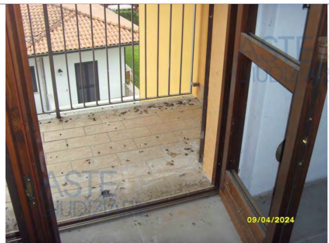
Sottotetto da recuperare in corso di costruzione
