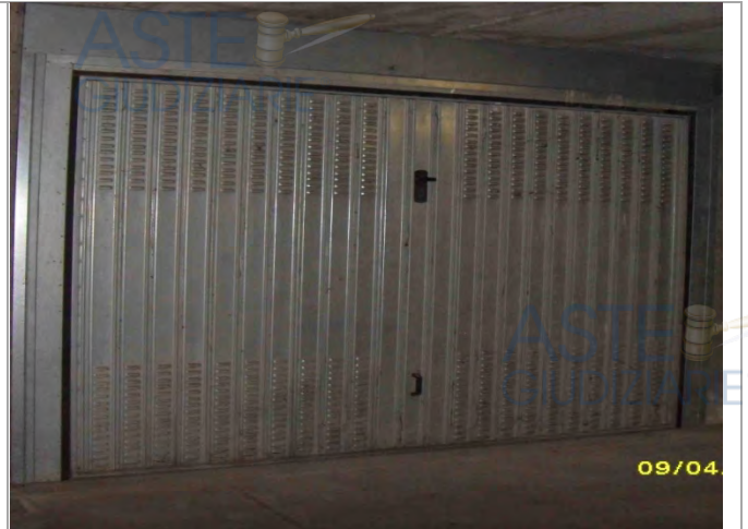
Piano Interrato in corso di costruzione
