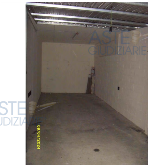
Autorimessa – p.lla 8760 sub 37
