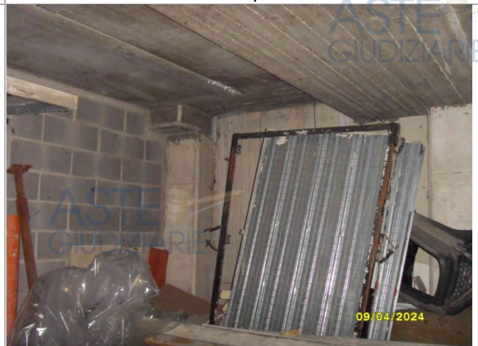
Piano Interrato in corso di costruzione
