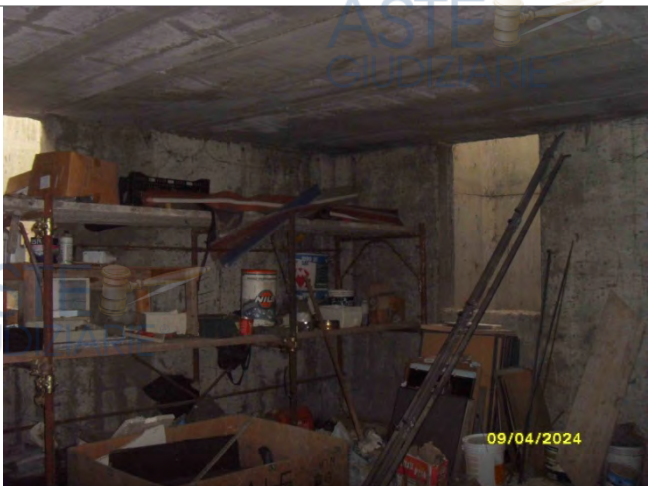
Piano Interrato in corso di costruzione
