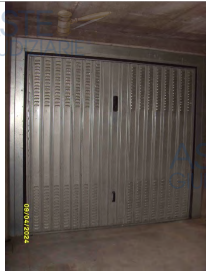
Autorimessa – p.lla 8760 sub 36
