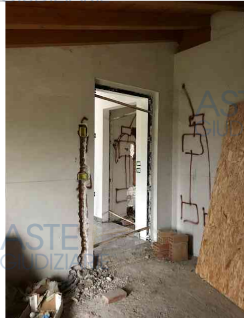
Ingresso sottotetto p.lla 8760 sub 19
