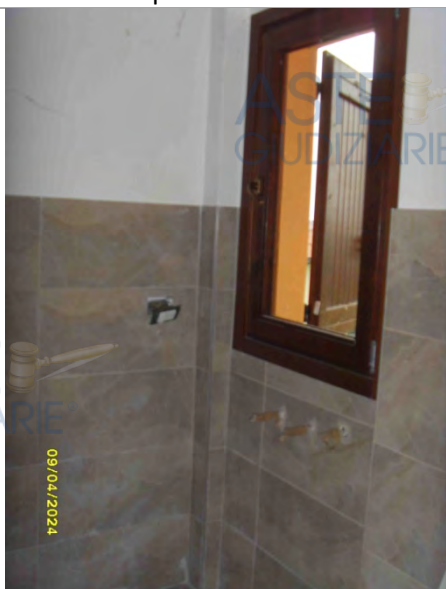
Sottotetto da recuperare in corso di costruzione
