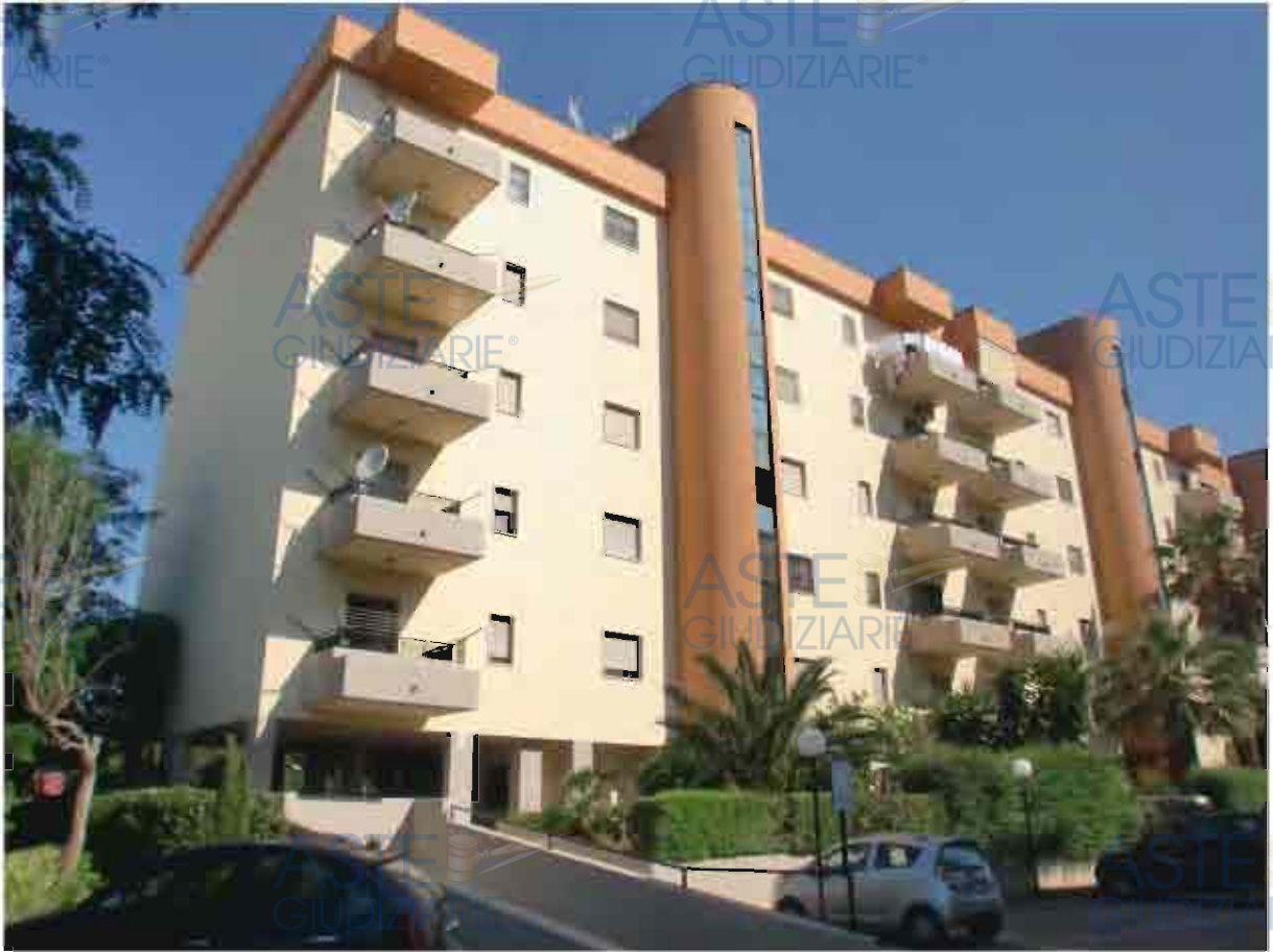
Prospetto Est del fabbricato in Casamassima (Ba) su Via Londra
